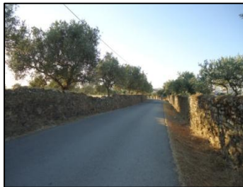
Figura 23 - Exemplo de muros de pedra seca/azinhaga (Julho 2012).
