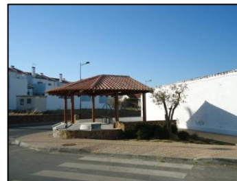
Figura 25 - Lavadouro do Poço de Ourique (Julho 2012).
