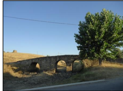
Figura 27 - Ponte antiga sobre a Ribeira de Cobres (Julho 2012).
