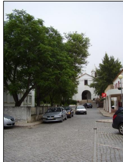
Figura 28 - Entrada da capela de Nossa Senhora da Conceição (Maio 2011).
