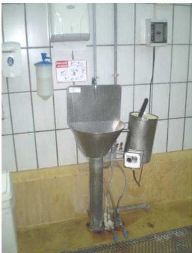
Fig. 6 Aparelho de desinfecção de utensílios. O matadouro dispunha de vários aparelhos com sistema de desinfecção de utensílios com água à temperatura mínima de 82°C, dispostos ao longo da linha de abate, de acordo com Regulamento (CE) nº 853/2004. (C. Bento 2010)
