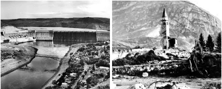
Fig. 15 e 16 Barragem Grand Coulee (1951) e área envolvente à Barragem Vajont após desastre (1960), respectivamente
