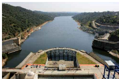
Fig. 45 Vista da Barragem de Alqueva, pág.63
