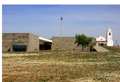
Fig. 52 Rampa de acesso ao pátio das amendoeiras e zona de entrada para o Museu, pág.77
