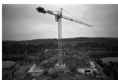
Fig. 51 Início das obras de salvaguarda do monumento, pág.73
