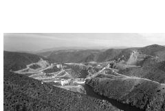
Fig. 58 Obras da Barragem do Côa, pág.95
