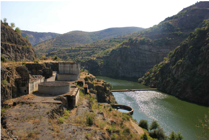
Fig. 67 Central Eléctrica da Barragem de Foz Côa
