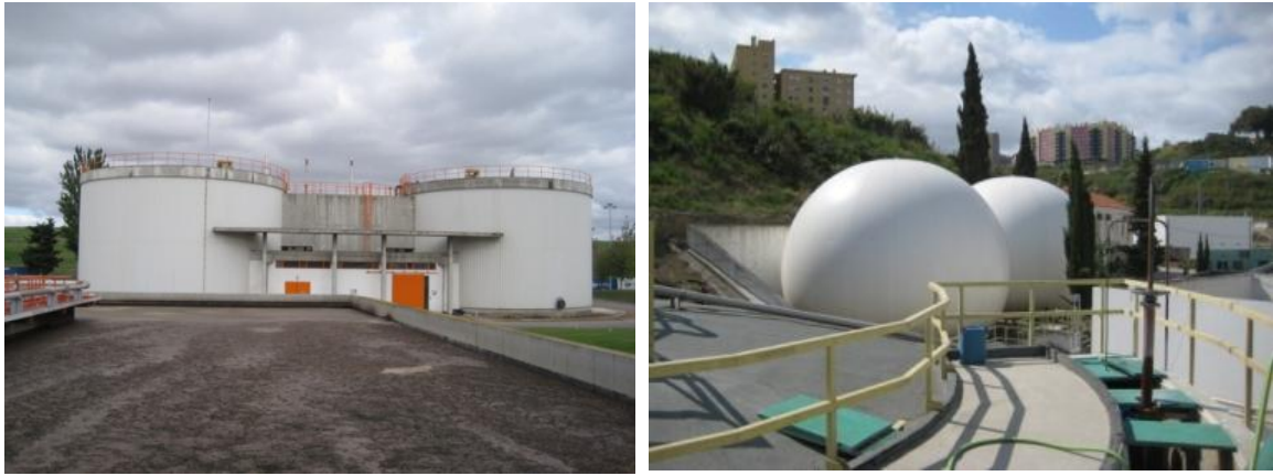
Figura 16 – Pormenor de biodigestores e gasómetros
