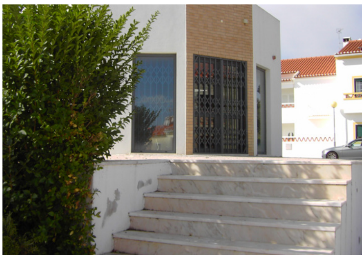
Figura 53. Acesso ao quiosque.
