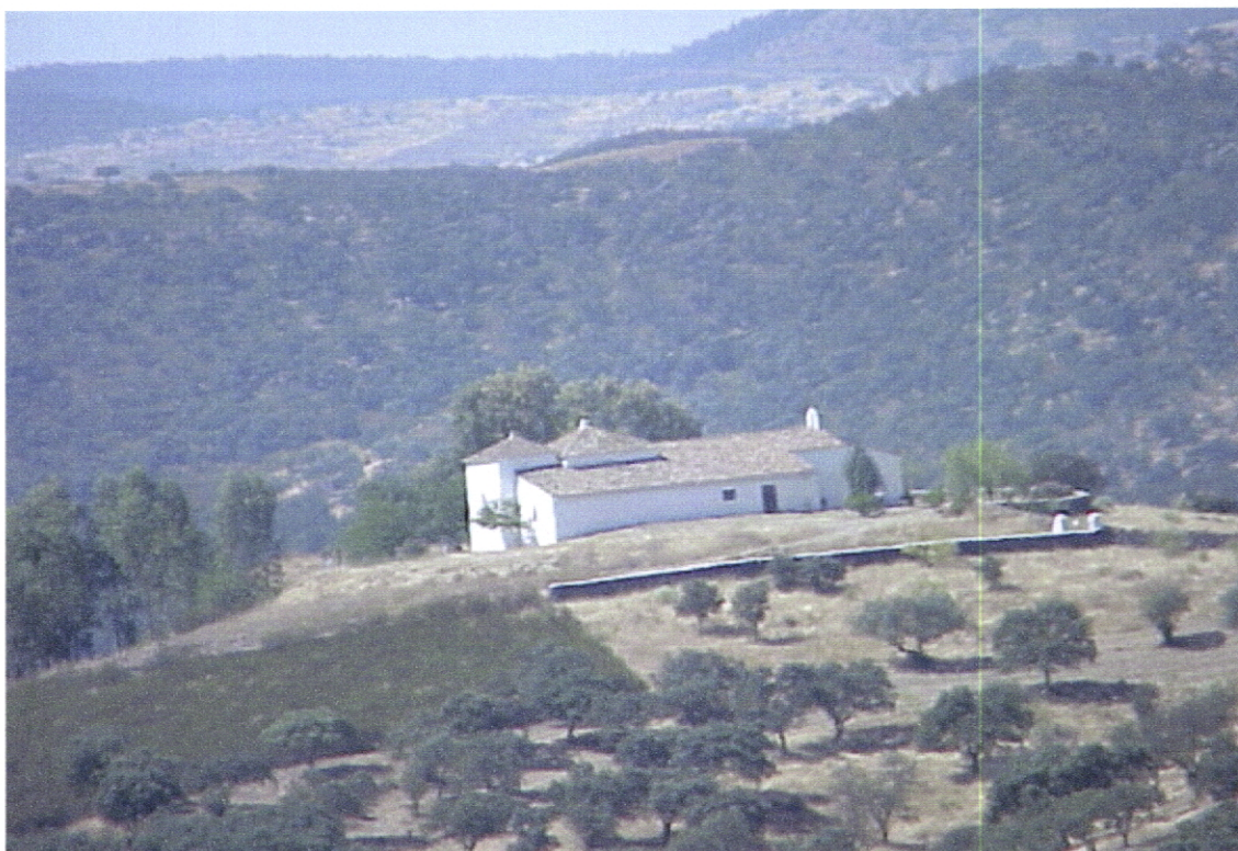
Fig. n.º 15: Monte ou "Cortijo" - situado na via de acesso Barrancos /Encinasola-
