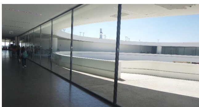
Imagem 4 - Interior do Edifício principal
