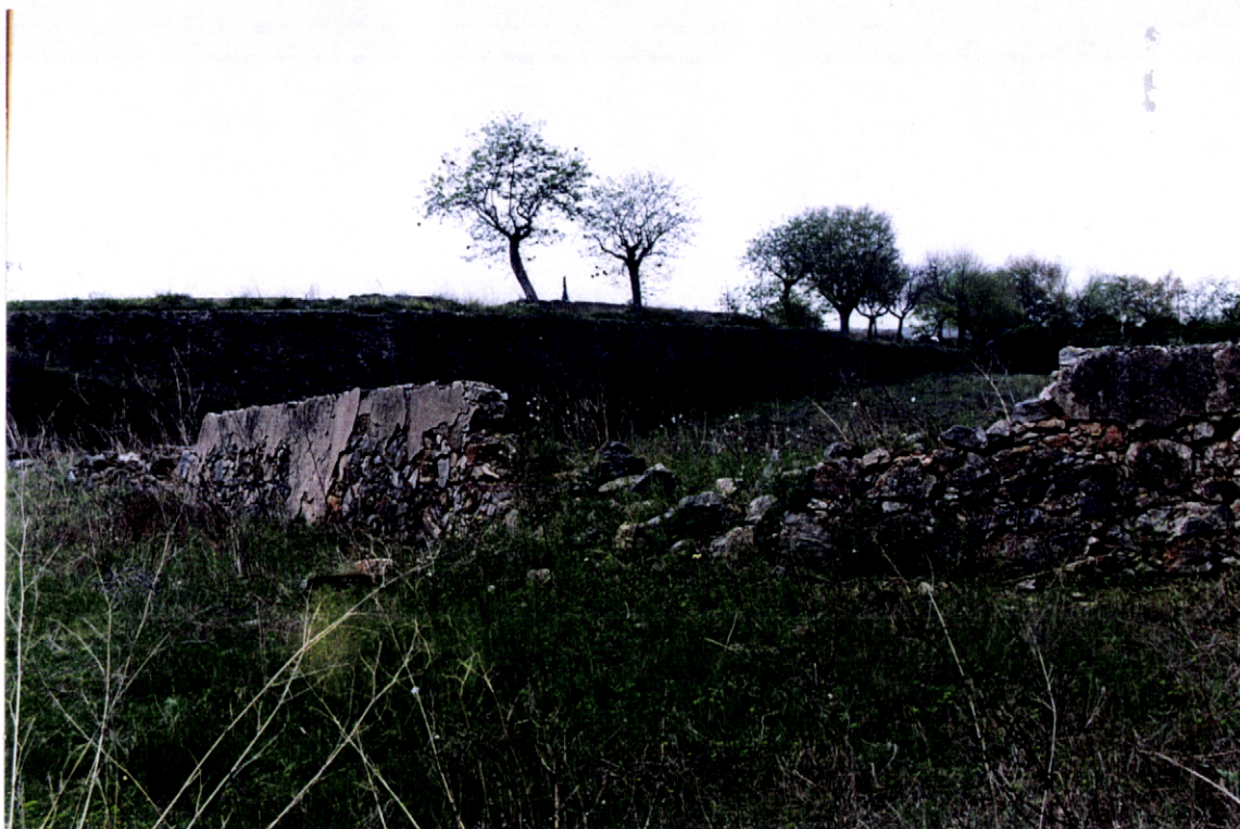
Fig. 156 – Muro em frente à Poterna de S. Pedro – a reconstruir
