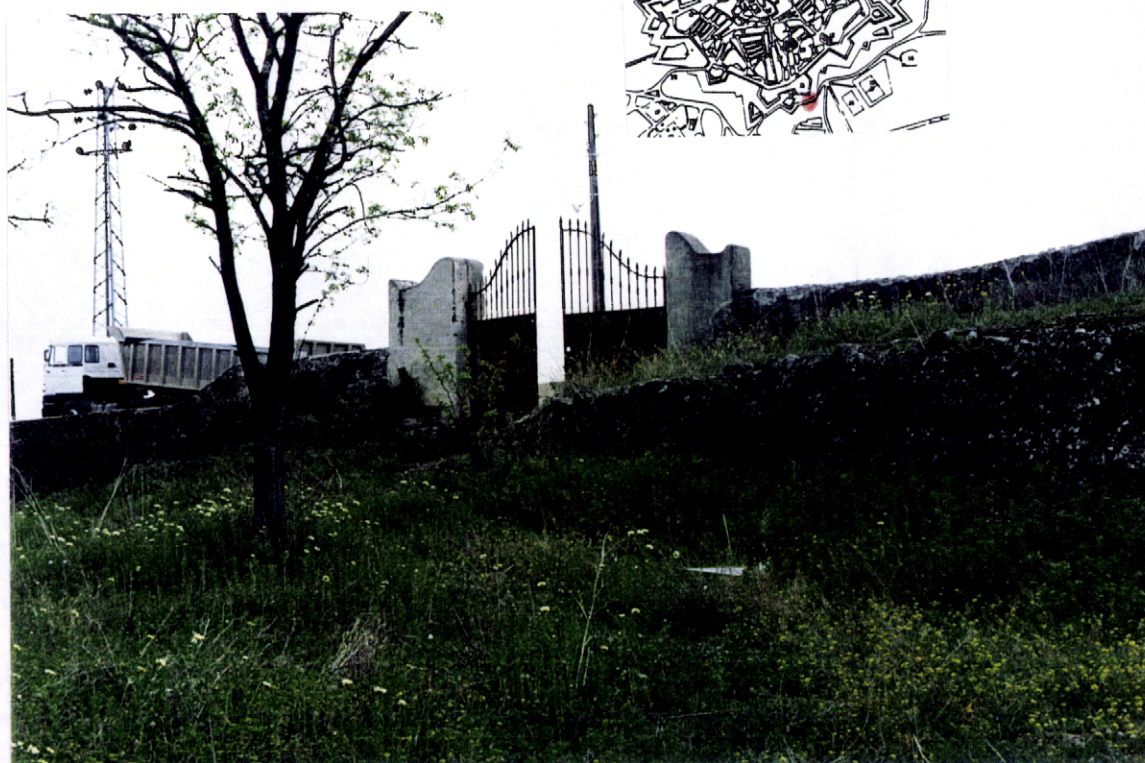
Fig. 139 – Acesso ao fosso
