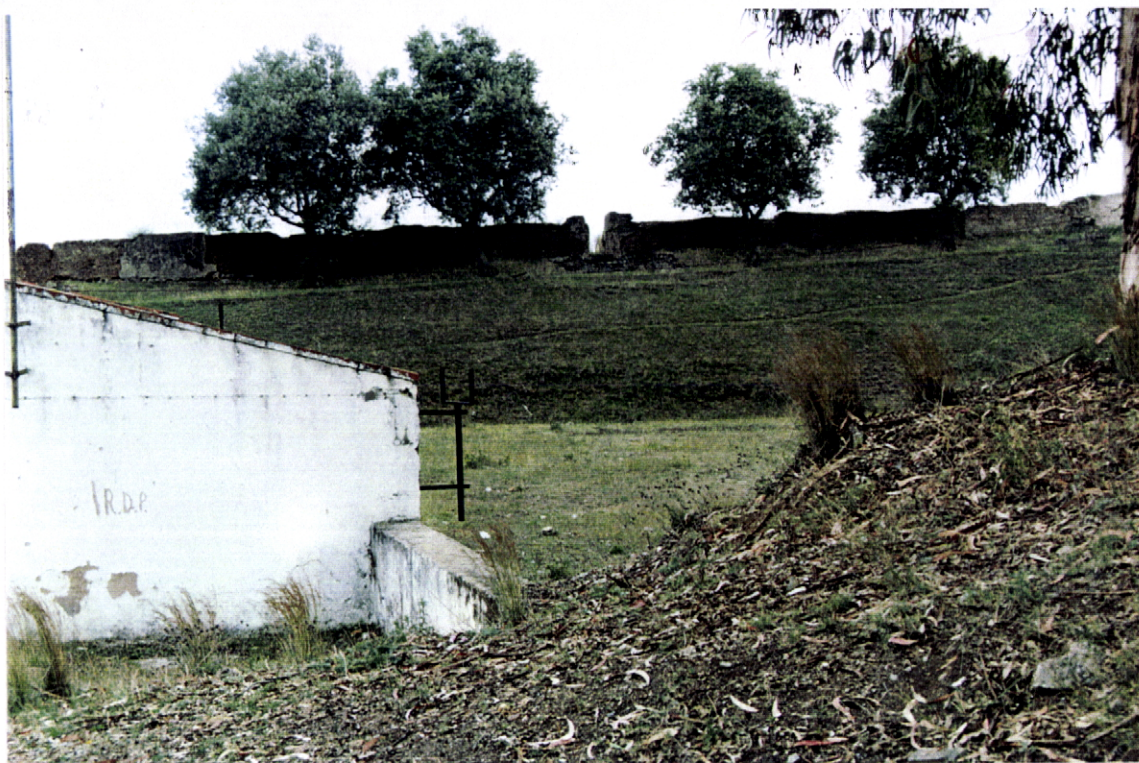
Figs 153 e 154 – Antigo campo de tiro militar Instalações a demolir
