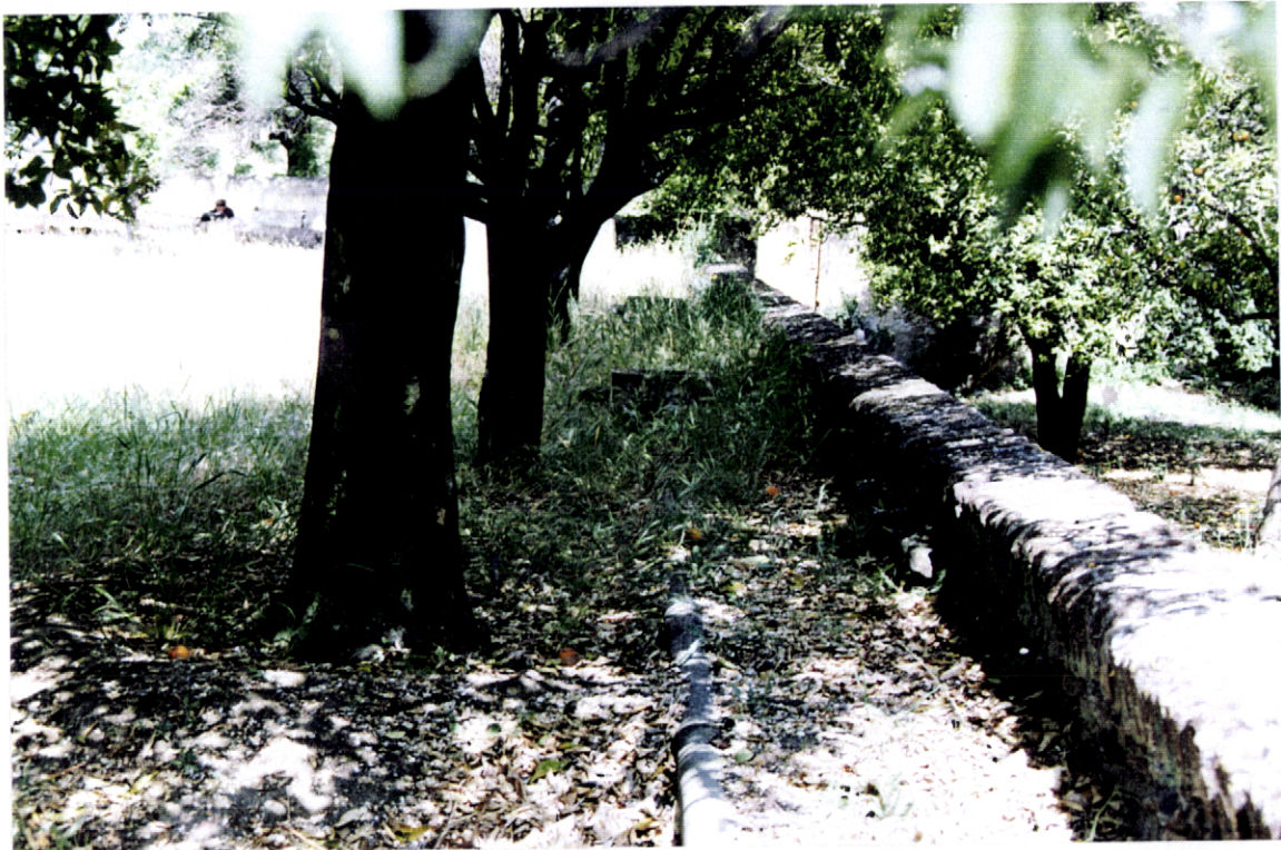
Fig. 145, 146 e 147 – Sistema de caleiras e bocas de rega
