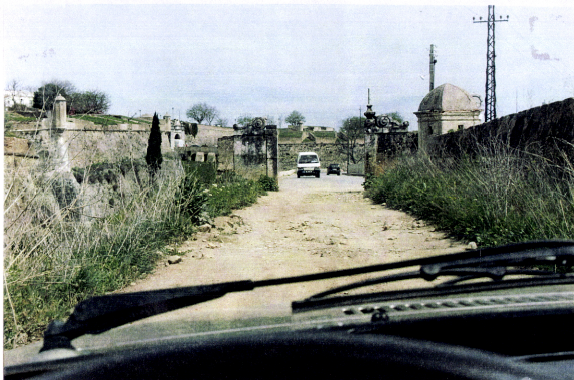
Fig. 138 – Acesso ao Fosso
