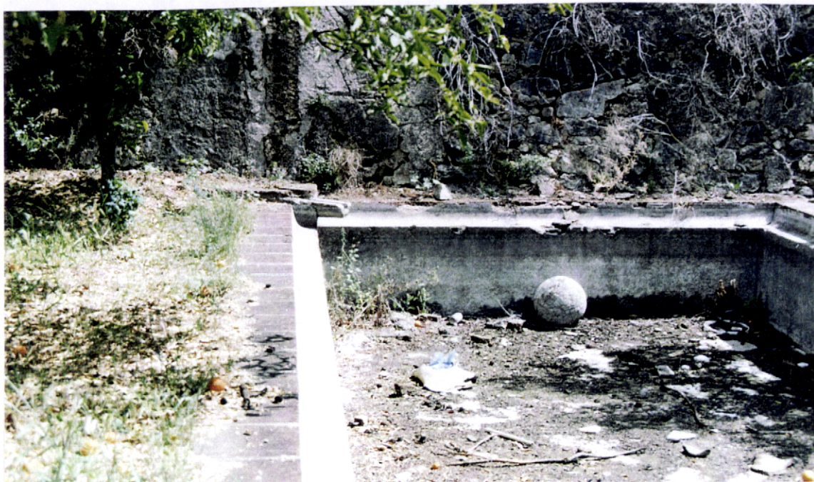
Fig. 115 – Jardim da Praça – tanque rectangular
