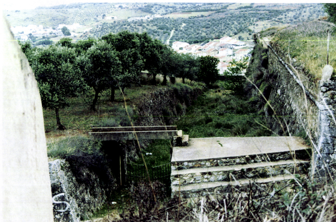
Fig. 76 – Pormenor do Fosso – zona das Portas de Esquina
