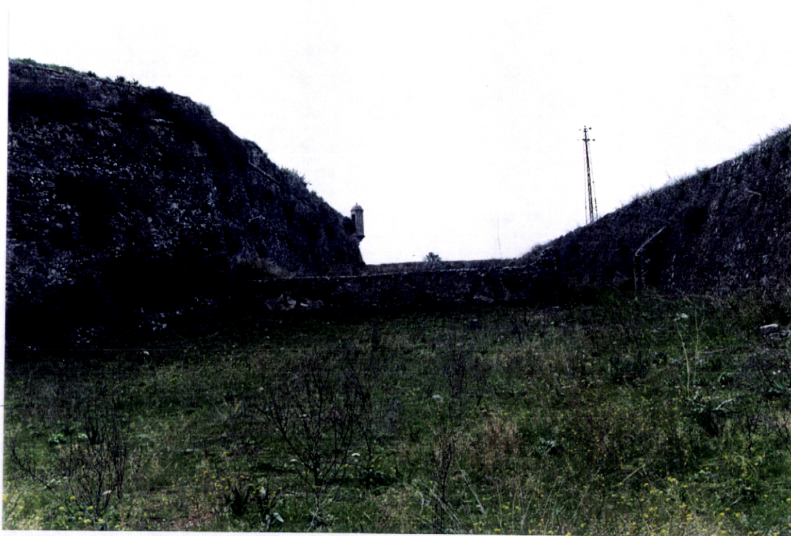
Fig. 108 – Pormenor da vegetação instalada na muralha.
