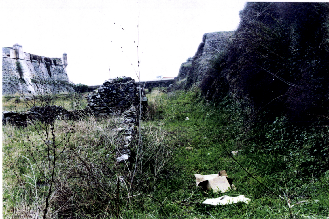
Fig.96 – Fosso – desmoronamento do muro; lixos diversos; vegetação nas muralhas
