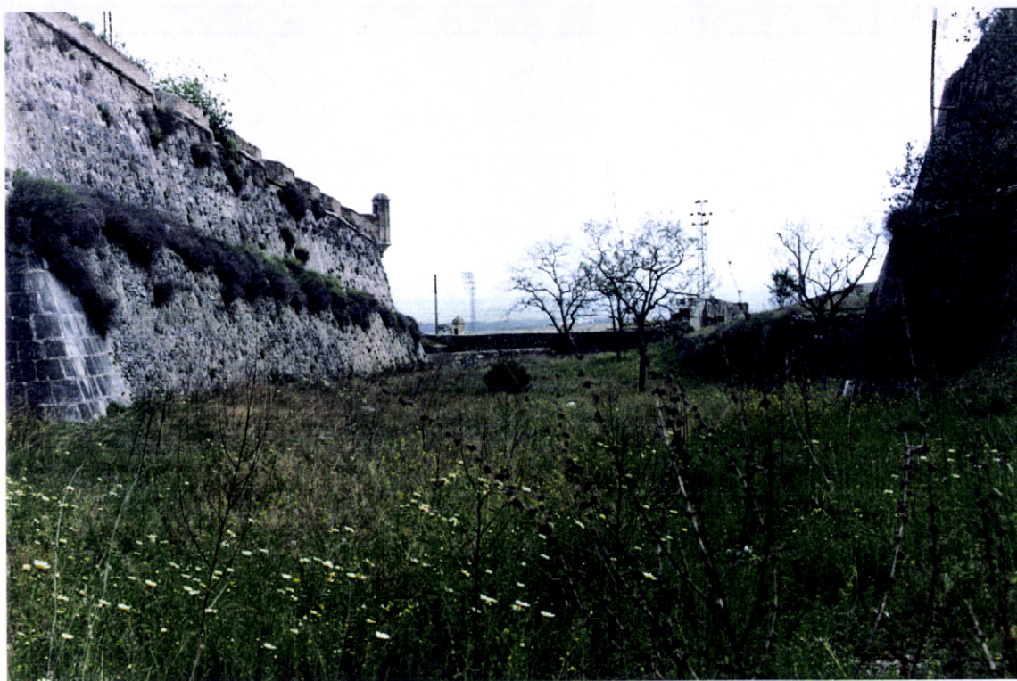
Fig. 111 – Fosso , junto às Portas de Olivença; vegetação na muralha
