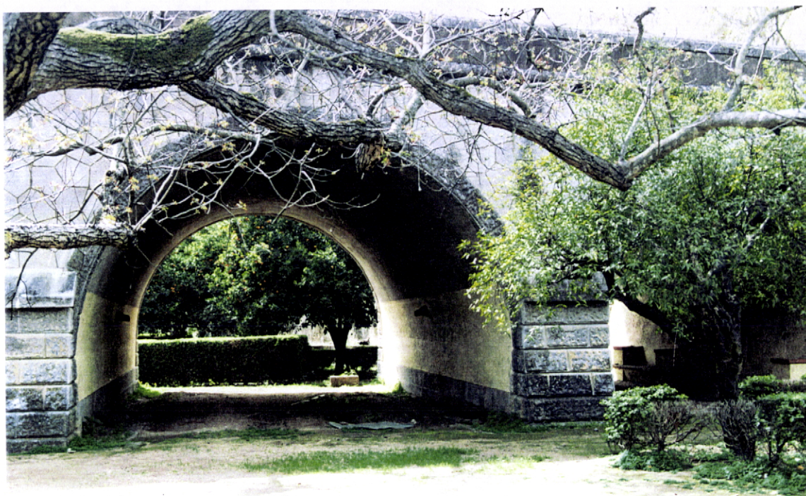
Fig. 57 – Jardim da Praça – pormenor da zona do viaduto
