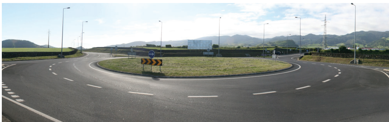
Figura 14 - Projeto de requalificação da rotunda da zona industrial. Fotografia do espaço de intervenção, com vista para Sudeste.
