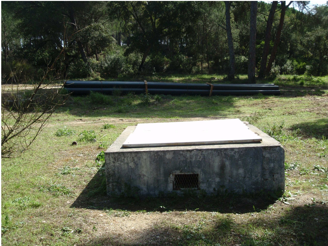
Figura 8: Aspecto geral da captação JK14
