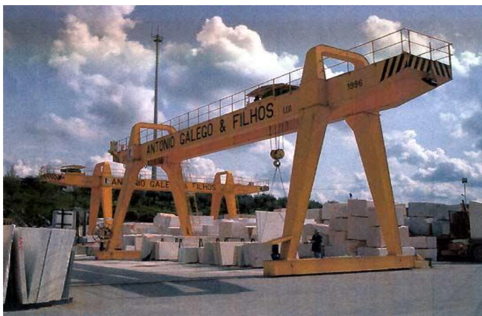
Foto 4.3 Pórtico para movimentação de blocos.
