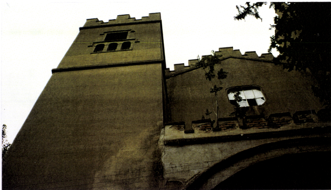
Fig.28. Convento do Carmo de Vidigueira. Fachada da igreja completamente ameada, inclusive a varanda que encima a galilé
