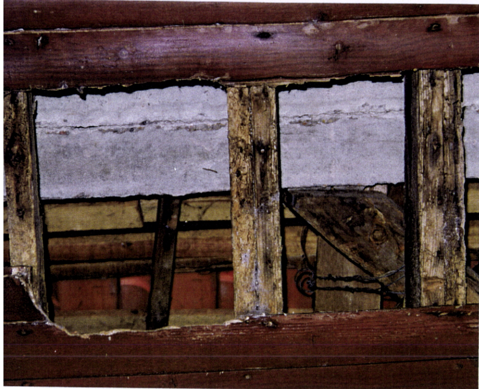
Fig. 98 - Convento do Carmo de Vidigueira. Traves e tabuado do tecto da coluna de escadas para a torre - ataque de carunchos e fungos
