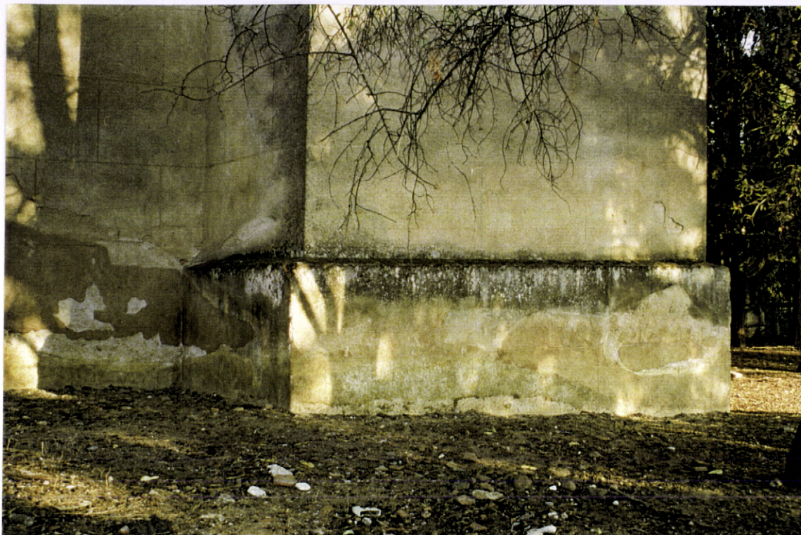
Fig. 33 - Convento do Carmo de Vidigueira. Igreja, torre norte. O embasamento das torres (um dos poucos vestígios da arquitectura gótica) recebeu igualmente a camada protectora de reboco. As “juntas da silharia” não estão alinhadas com as da parede ao lado. Eis um pormenor que foi ignorado: se houvesse rigor (mesmo numa imitação), haveria a preocupação em alinhar as “juntas das pedras”, uma vez que foram “colocadas” na mesma altura
