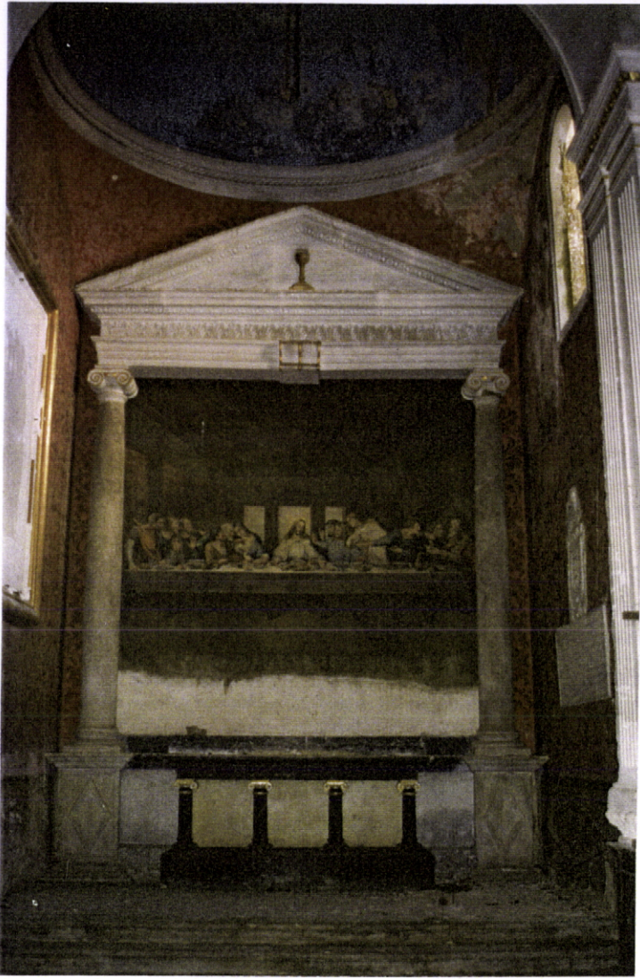
Fig. 58 – Convento do Carmo de Vidigueira. Igreja, capela lateral do lado do Evangelho. Pórtico altar em mármore. O conceito de mimetismo com o objectivo de dar certa uniformidade cromática também implica a pintura dos materiais pétreos, como é o caso do pórtico em mármore que já só se conserva nalgumas peças pintadas, nomeadamente o embasamento e os fustes das duas colunas jónicas, a imitar...mármore. O frontão e a arquitrave sofreram operações de limpeza que retiraram a maior parte da pigmentação. As paredes laterais apresentam um roda-pé em estuque com o mesmo motivo em losângulo do embasamento que apoia as colunas
