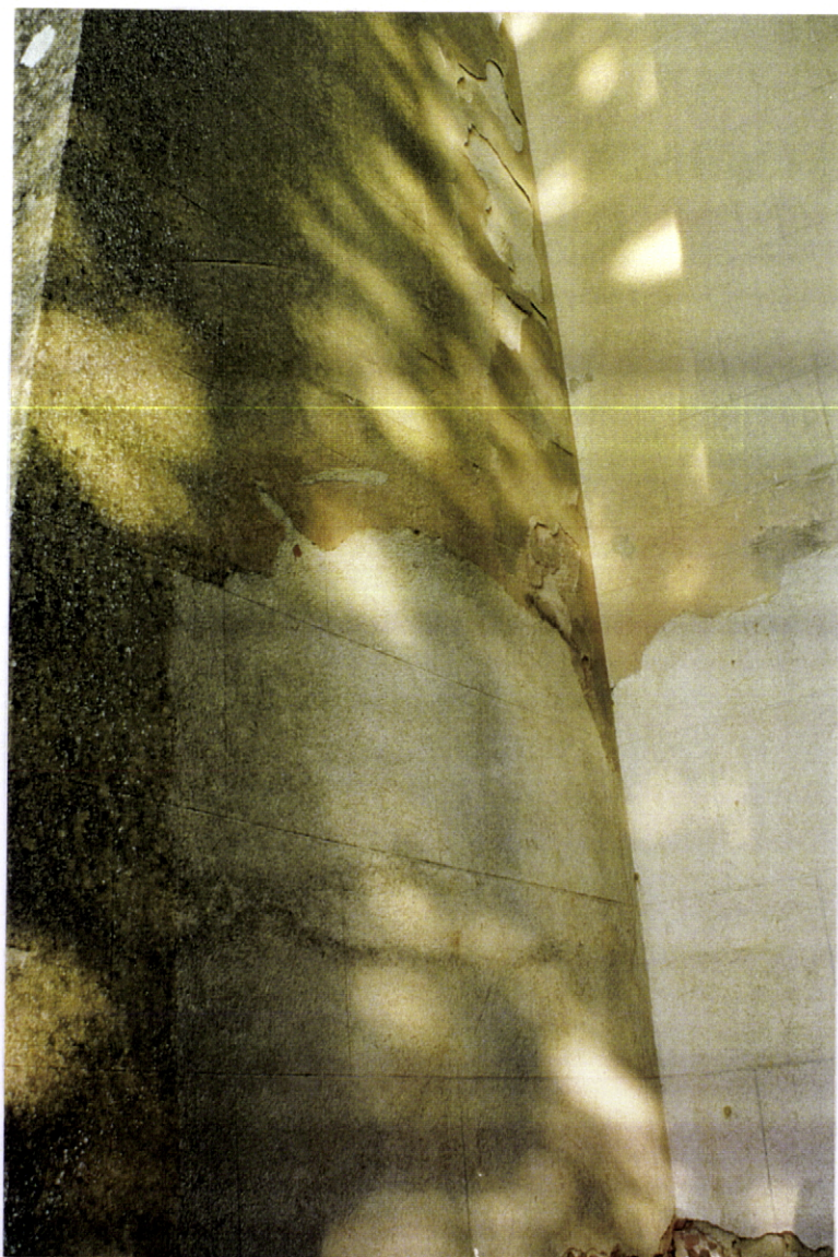
Fig. 33 - Convento do Carmo de Vidigueira. Igreja, torre norte. O embasamento das torres (um dos poucos vestígios da arquitectura gótica) recebeu igualmente a camada protectora de reboco. As “juntas da silharia” não estão alinhadas com as da parede ao lado. Eis um pormenor que foi ignorado: se houvesse rigor (mesmo numa imitação), haveria a preocupação em alinhar as “juntas das pedras”, uma vez que foram “colocadas” na mesma altura
