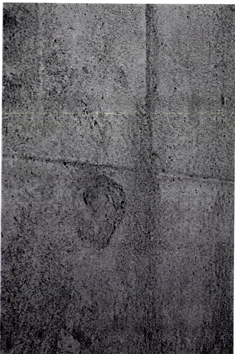
Fig. 36 – Convento do Carmo de Vidigueira. Pormenor das “juntas” da silharia e espessura do reboco de simulação de uma parede
