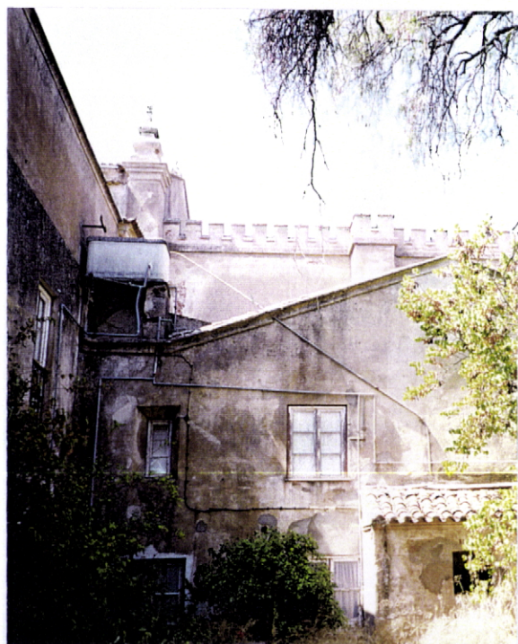
Figs. 69, 70 e 71 - Convento do Carmo de Vidigueira.
