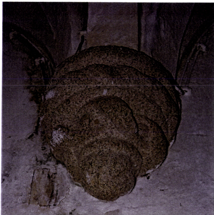
Fig. 100 - Arenização numa mísula de granito
