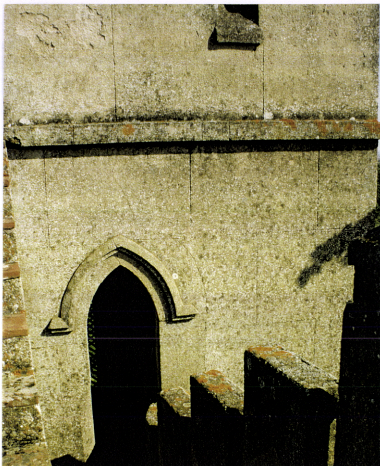
Fig. 37 – Convento do Carmo de Vidigueira. Igreja, torre sul. Exemplo de simulação de uma cantaria, em argamassa. Idem, para com a simples cimalha de demarcação de pisos, que apresenta as “juntas das pedras”
