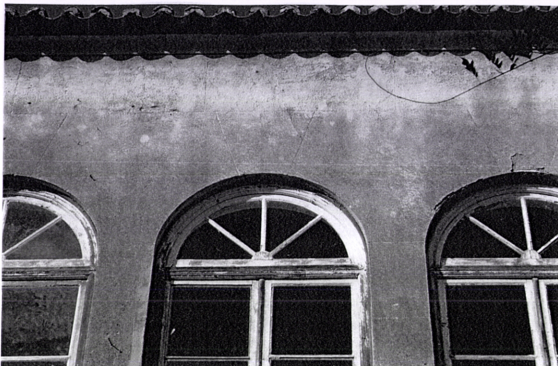
Fig. 35 - Convento do Carmo de Vidigueira. Claustro, piso superior, ala nascente, parede orientada a poente. Pormenor do reboco de simulação: o arco das janelas é rematado por uma “pedra de fecho”
