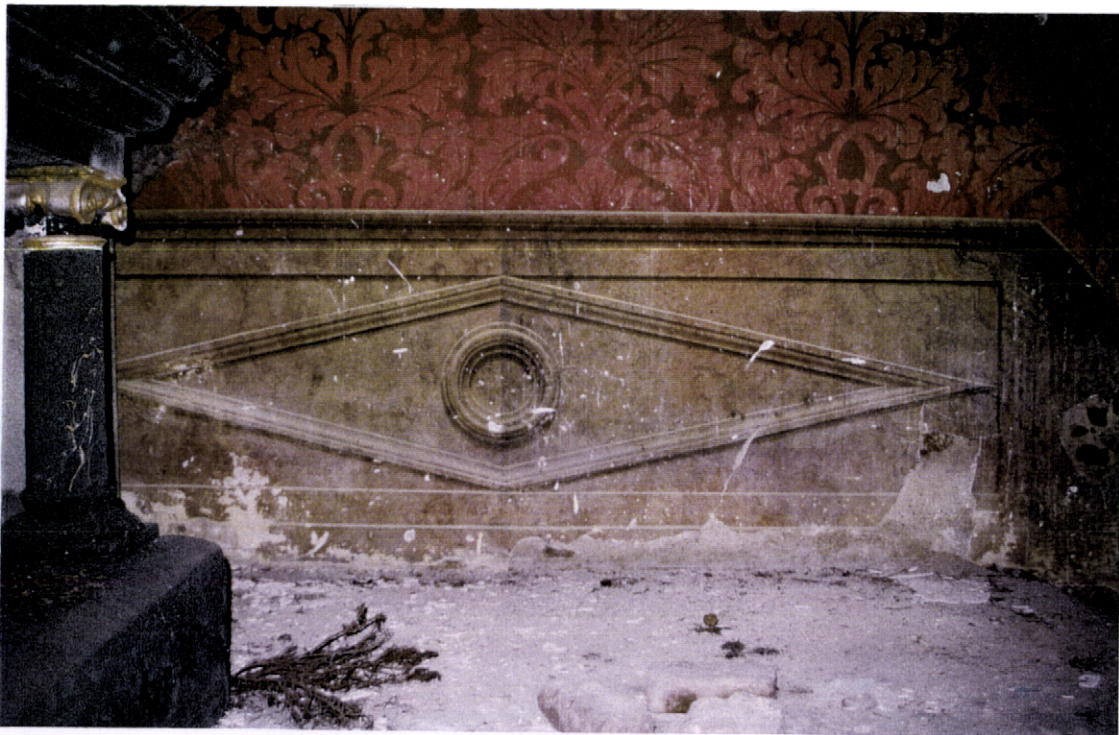
Fig. 59 - Convento do Carmo de Vidigueira. Igreja, capela lateral do lado do Evangelho. Simulação de um roda-pé em brecha cor creme, com relevos pintados (a avaliar pela qualidade e perfeição das sombras)
