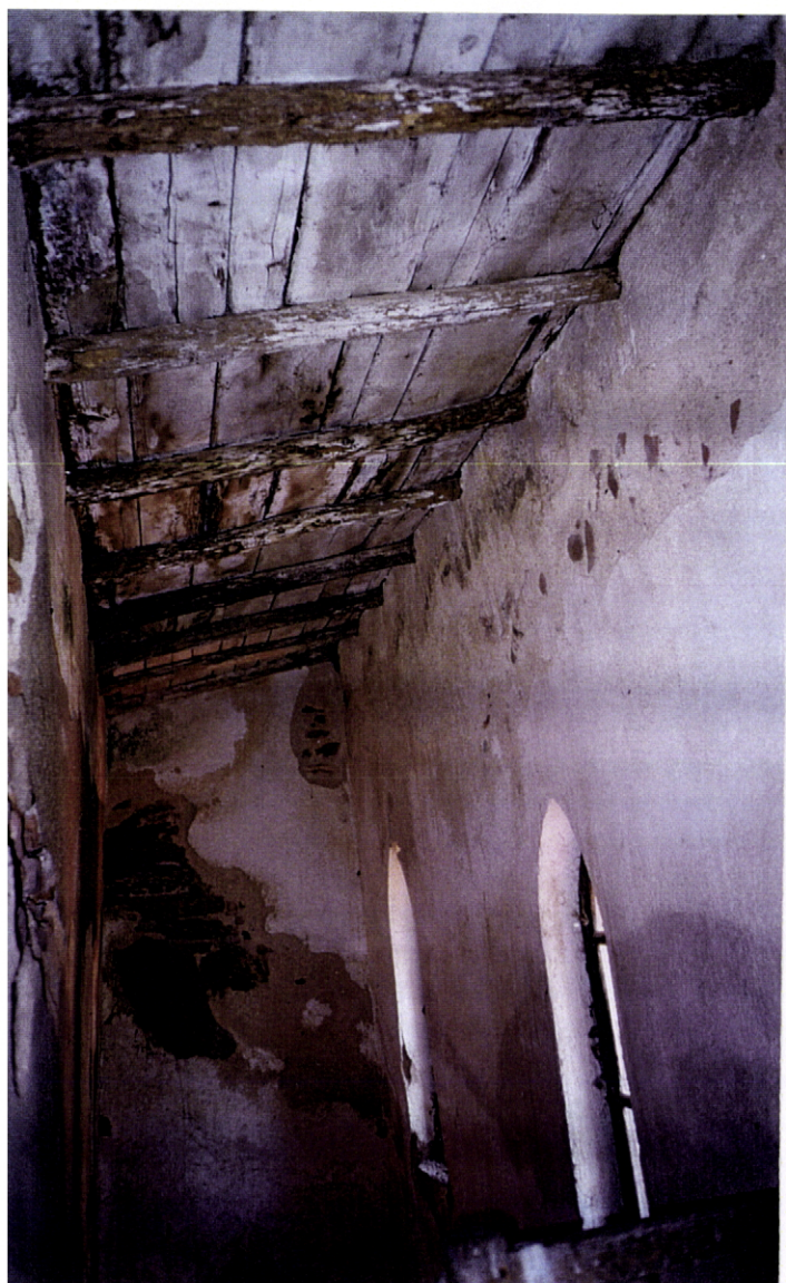
Fig. 98 - Convento do Carmo de Vidigueira. Traves e tabuado do tecto da coluna de escadas para a torre - ataque de carunchos e fungos
