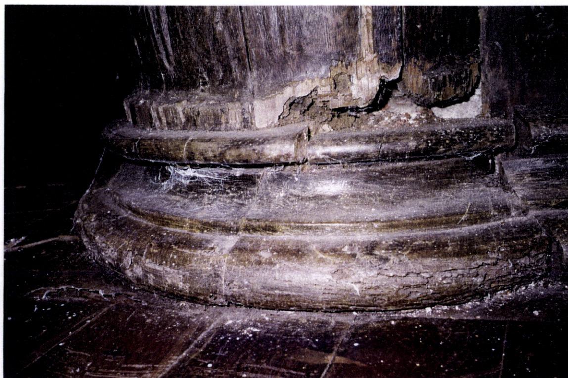
Fig. 96 - Convento do Carmo de Vidigueira. Coluna do retábulo renascentista (base) - idem
