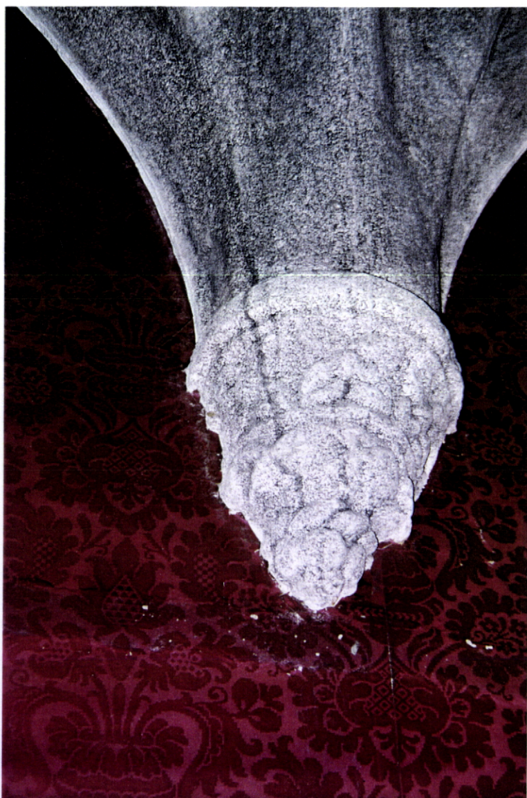
Fig. 49 - Convento do Carmo de Vidigueira. Refeitório. Pormenor da ligação entre a mísula e as nervuras. Onde acaba o granito e começa o estuque pintado?
