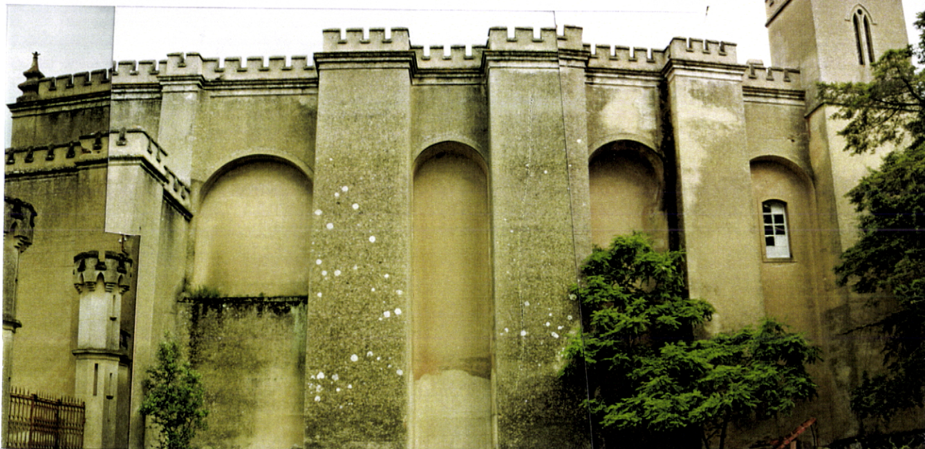
Fig. 32 - Convento do Carmo de Vidigueira. Igreja, alçado lateral norte, cunhal do contraforte. Observe-se a estratificação de rebocos: 1. primeira camada de argamassa (original?) sobre a alvenaria de pedra irregular; 2. bocadinhos de tijolo entre as duas argamassas, que servem de superfície irregular para uma melhor aderência da argamassa de simulação à primeira. 3. Reboco de simulação numa camada grossa em fissuração e desagregação devida à diferente natureza das duas argamassas. Repare-se na curiosa analogia entre o “grão” da argamassa - da própria textura da areia e da acção biológica (clima, líquens, fungos, etc.) -, e o de um bloco de granito (a verdadeira silharia em pedra que reforça o cunhal)
