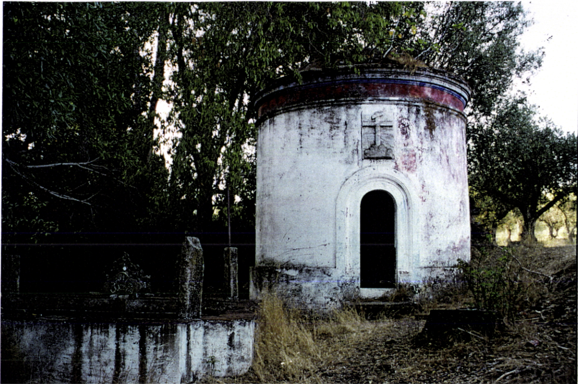
Fig. 16 - Convento do Carmo de Vidigueira. Ermida de Sta. Luzia junto aos tanques de lavagem e de rega.
