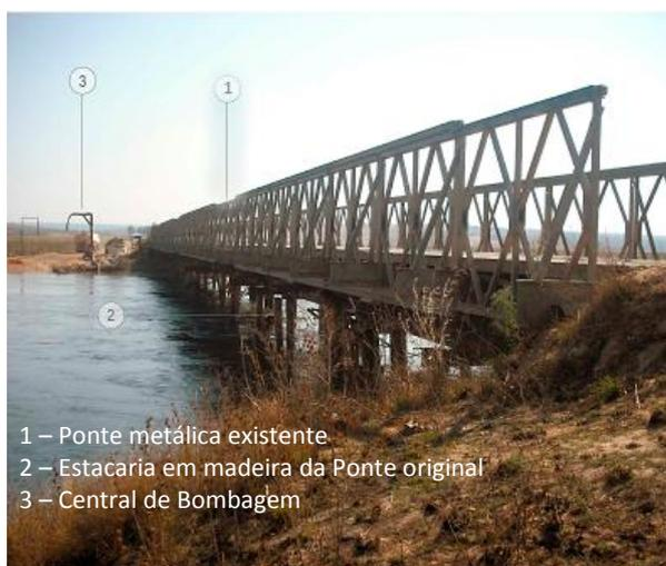
Figura 3 - Entreposto Cuito: Ponte existente
