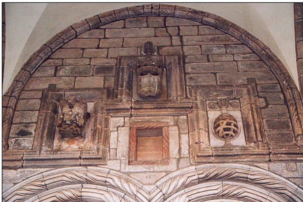
Fig.11 - Vista da parte superior da porta principal.
