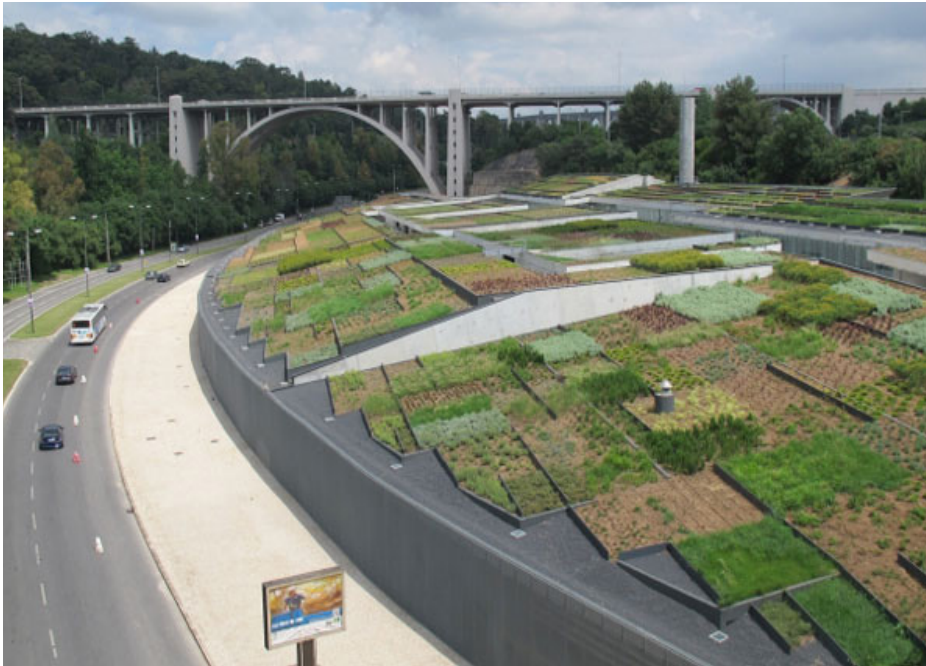
Figura 1 - Cobertura verde da ETAR de Alcântara.
