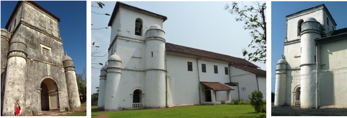
Figs. 6, 7 e 8 – Vistas da Igreja de Nossa Senhora do Rosário – Alçados principal e lateral.
