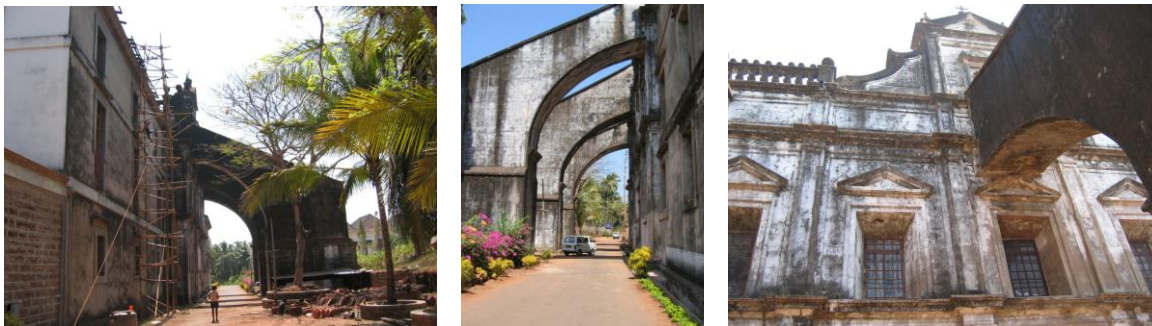
Figs. 73, 74 e 75 – Vistas dos contrafortes que foram posteriormente construídos. Na figura 73 é visível que são de época mais tardia que o resto da igreja.
