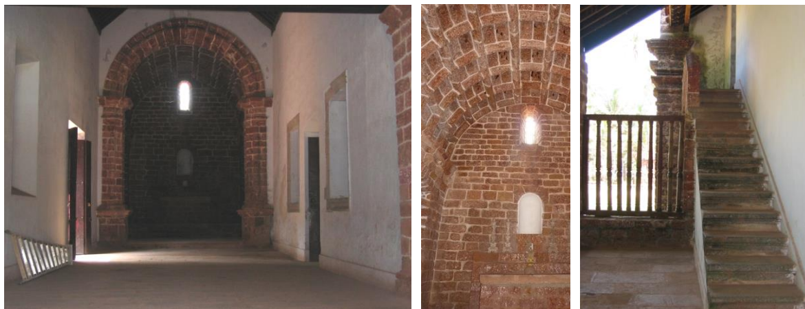
Figs. 62, 63 e 64 – Vistas do interior da nave, capela-mor e de uma escada exterior.
