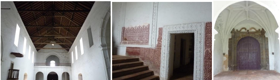
Figs. 9, 10 e 11 – Vistas da Igreja de Nossa Senhora do Rosário – Interior da nave e pormenores do portal de acesso.
