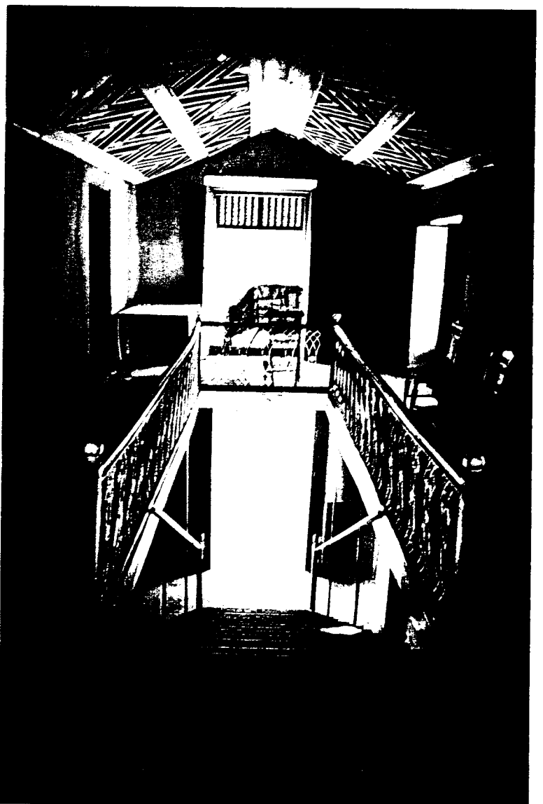
Foto 46 -Sobrado da casa Gonçalves (Guirim -Bardez) com vigamento de madeira a suportar o lajedo de laterite. Em baixo o tecto de grande efeito decorativo das escadas principais da mesma casa.
