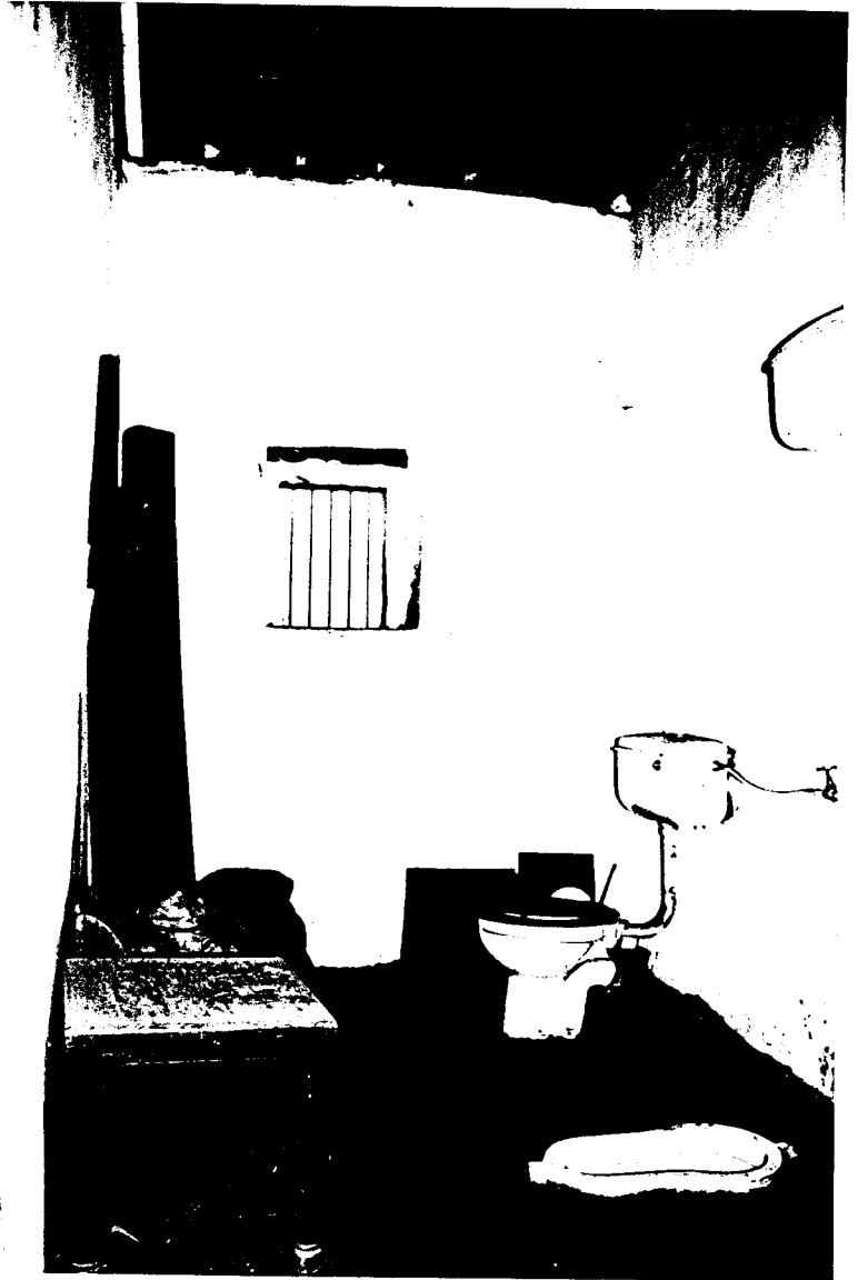
Foto 105 -Aspecto do interior do antigo cumão, hoje adaptado e vista do alçado lateral esquerdo onde se localiza a fossa séptica.
