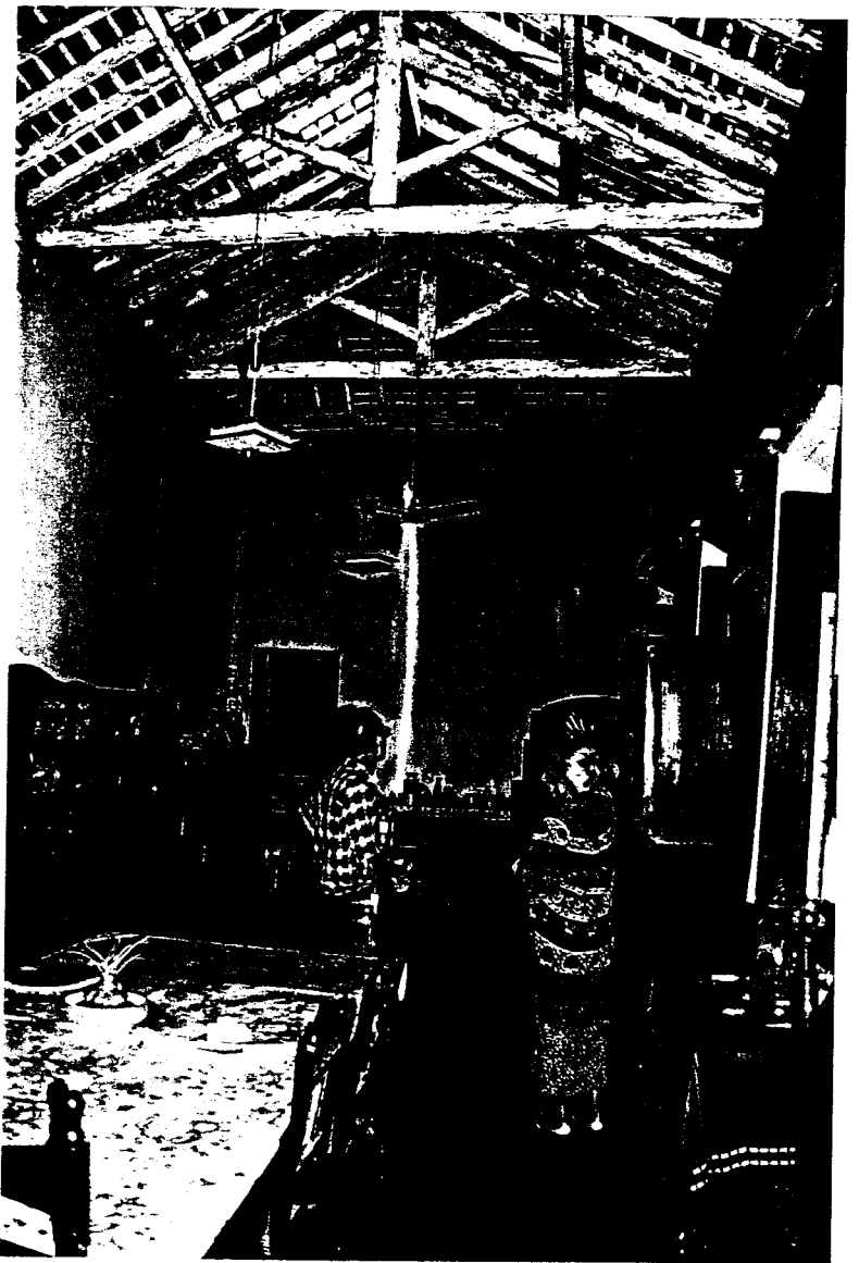
Foto 45 -Em cima estrutura à vista de madeira, caída para prevenir do bicho, da casa Carvalho II (Chandor -Salcete). Em baixo, o tecto em caixotão da sala da casa Fernandes (Chandor -Salcete).
