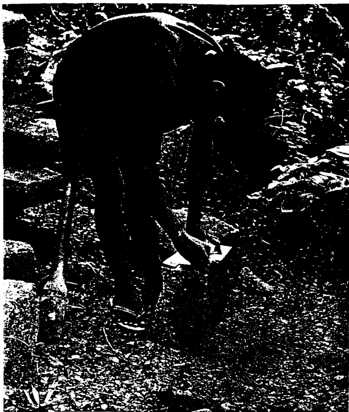
Foto 69 Aspecto do talhe dos blocos em obra. Neste caso e com base num molde são cortadas cornijas (em cima). À direita, em baixo, vista do processo de extracção e dos instrumentos utilizados para o feito.
