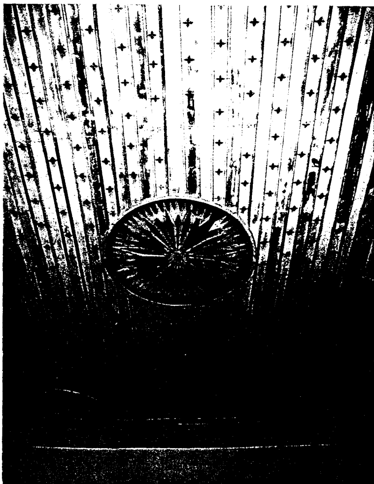
Foto 44 -aspecto dos tectos decorativos de madeira, com aberturas para a ventilação. Do lado direito a casa Castilho Noronha (Neura -Ilhas) e do esquerdo a casa Cabral Furtado (Nagoá -Salcete).
