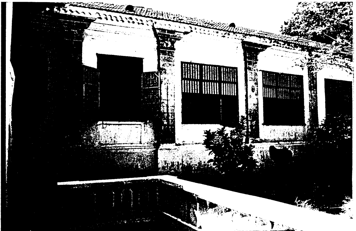
Foto 50 -Fachada principal da casa Monteiro, datada do séc. XVII, exemplo precioso de arquitectura maneirista no panorama das casas de Goa (em cima). Em baixo fachada lateral da casa Alemão (Betalbatim -Salcete), onde os vãos largos de carepas alternam com pilastras que simulam cantaria cinzenta.
