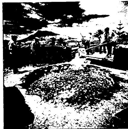
Campo de Baixo, Porto Santo: Forno de Cal - carregando o forno até acima, vendo-se o carvão de pedra formando camada inferior à pedra calcária.
