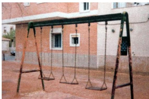
**Figura 13** – Baloiço que segundo as normas europeias já não é permitido. Para além de ter três assentos na mesma estrutura, apresenta-se feito em ferro e com a barra lateral que possibilitada a criança a colocar-se de pé em cima da mesma. (Fonte: RODRIGUES, 1999)
