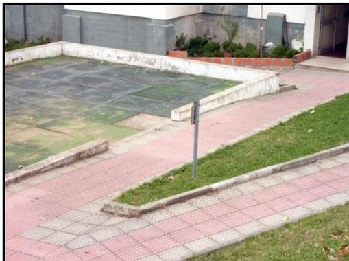
**Figura 58** – Vista para a entrada de uma das plataformas onde se nota o pavimento gasto com a falta de placas. (Fotografia da autora)
