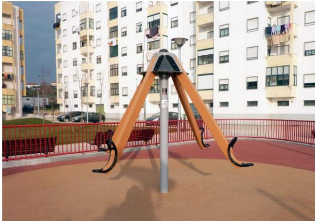
**Figura 10** – Os equipamentos que apresentem um ponto de suporte de toda a estrutura, quando implementados em superfícies de difícil acesso às suas fundações, deveriam possuir (neste caso não possui) uma caixa de visita de forma a assegurar a sua estabilidade, segurança e o seu bom funcionamento. (Fotografia da autora)
