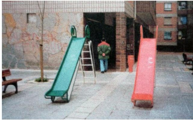
**Figura 11** – Escorrega com zona superior muito exposta a possíveis quedas bem como a zona inferior sem qualquer protecção na zona de impacte. (Fonte: RODRIGUES, 1999)
