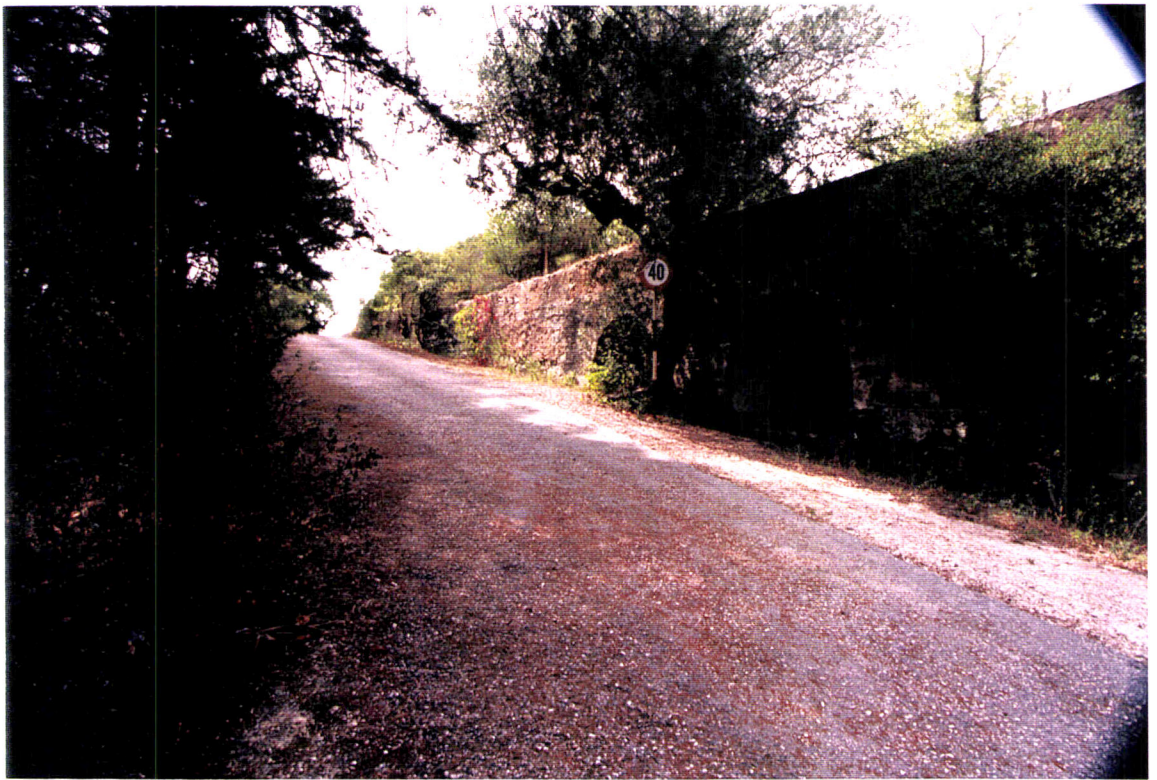
Fotografia 29. Um trecho do aqueduto integrado na Mata.
