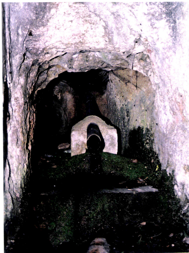
Fotografia 45 Pormenor da boca da mina, com a encanação da água.
