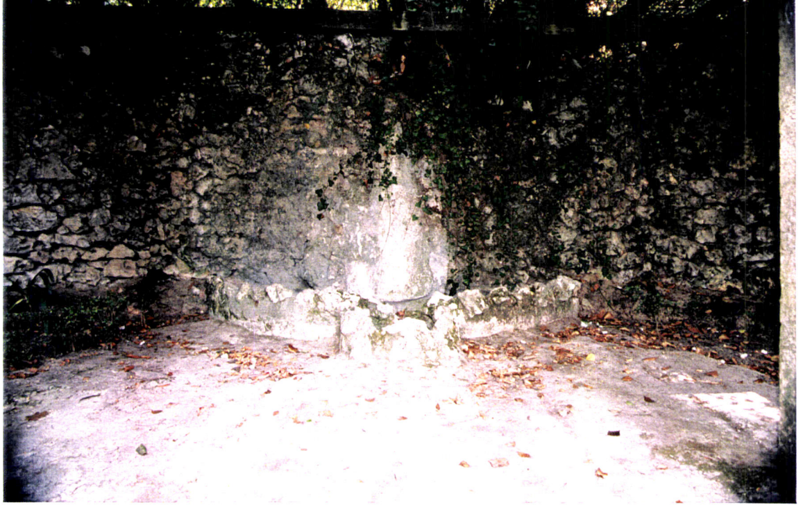
Fotografia 56 A "Fonte dos Jasmins", pormenor da parede e do tanque.
