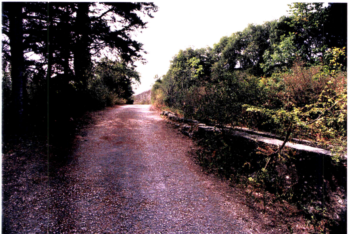
Fotografia 30. Pormenor de uma passagem do aqueduto a conduta subterrânea.
