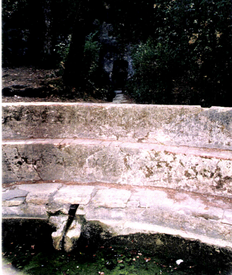
Fotografia 44 Pormenor da entrada da mina do tanque da Charolinha (ao fundo).
