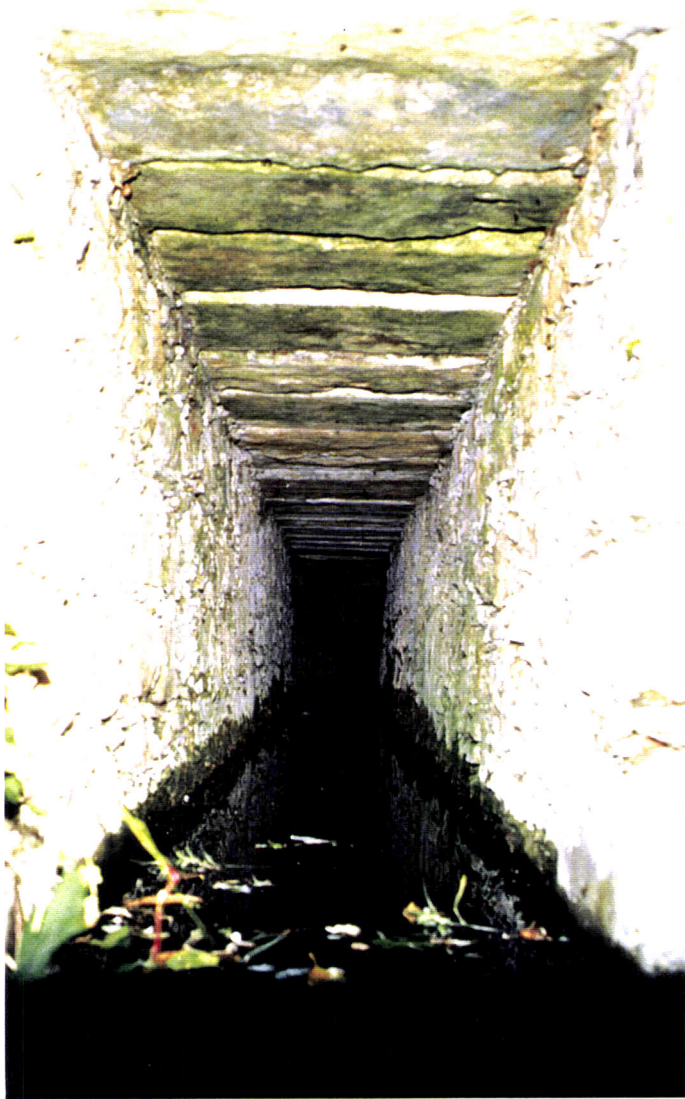
Fotografia 16. O túnel do ramal da nascente do Castelo.
