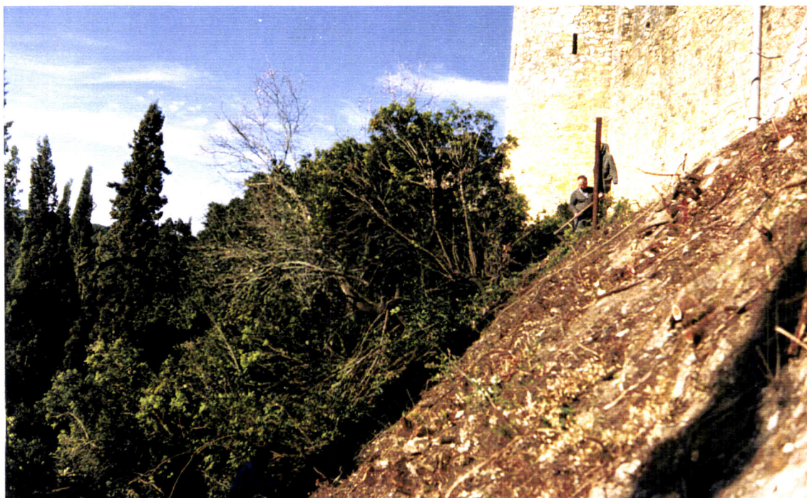
Fotografia 41 Pormenor da terra e do mato sobre o alambuarte da muralha, em 1987
