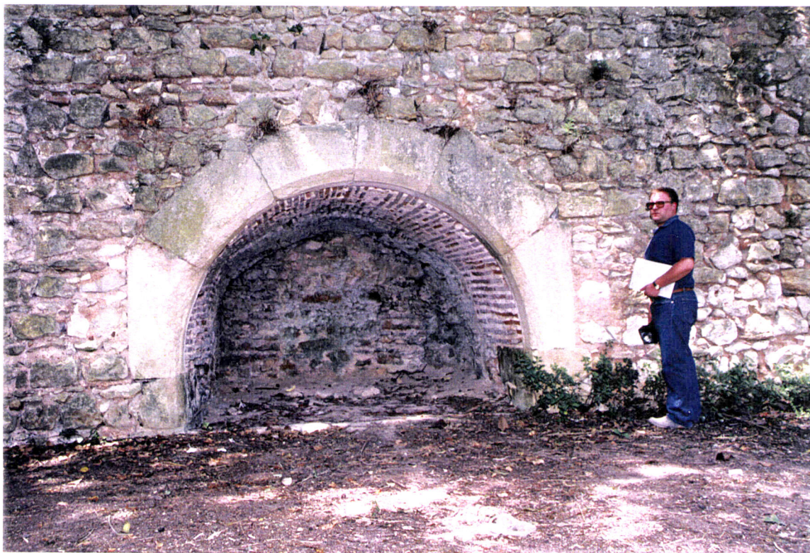
Fotografia 21. A boca da fonte (entaipada) do ramal da cisterna do claustro dos Corvos.
