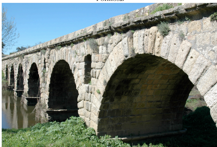
Via XIV: ponte romana de Vila Formosa entre Ponte de Sôr e Alter do Chão
