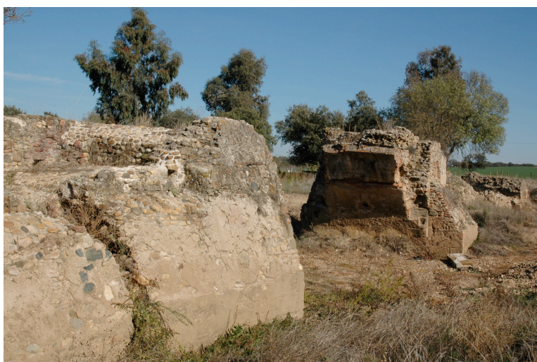
Via XV: alicerces da ponte romana de N. Sr a da Enxara (Campo Maior).
