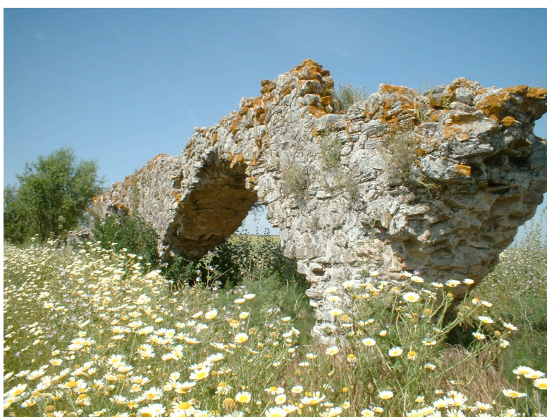
Correio-Mor (08.40): vista parcial do aqueduto.
