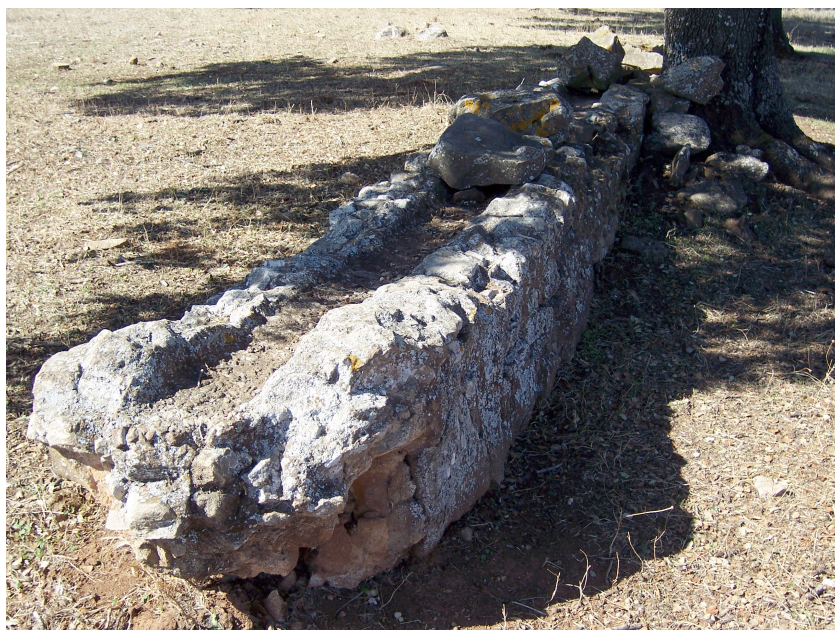
Pomarinho de Torre das Arcas (08.29): troço conservado de conduta de água, provavelmente a terminação de um aqueduto.
