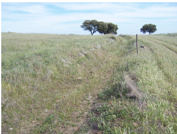
Possível nó viário entre os itinerários XIV e XV: próximo de Monte do Reguengo (Arronches), um troço de via rebaixado em relação ao solo envolvente e com guardas laterais em pedra.
