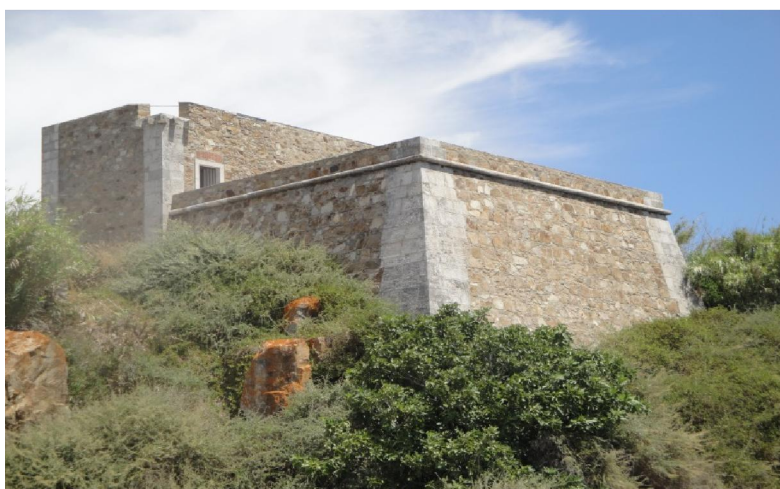
Forte de Nossa Senhora das Salas – Bateria virada ao mar
