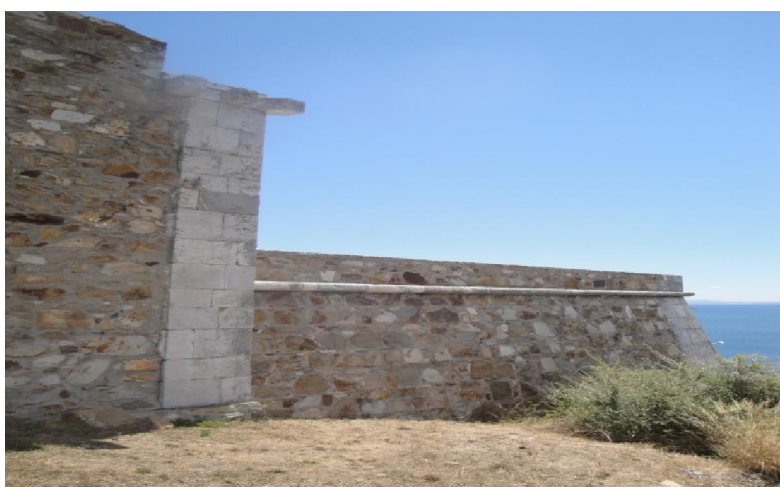
Forte de Nossa Senhora das Salas – Bateria virada ao mar (alçado norte)
