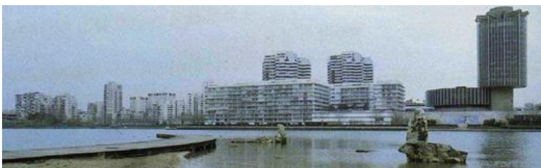
Figura 2.30 – Imagem de uma bacia de detenção localizada em Créteil-Préfecture , Paris, França (MATIAS, 2006).
