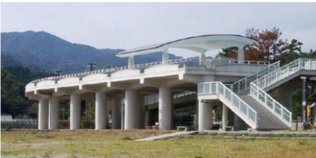
Figura 2.37 – Imagem de um abrigo para 700 pessoas, localizado em Shirahama Japão (UAF-GI, 2010).
