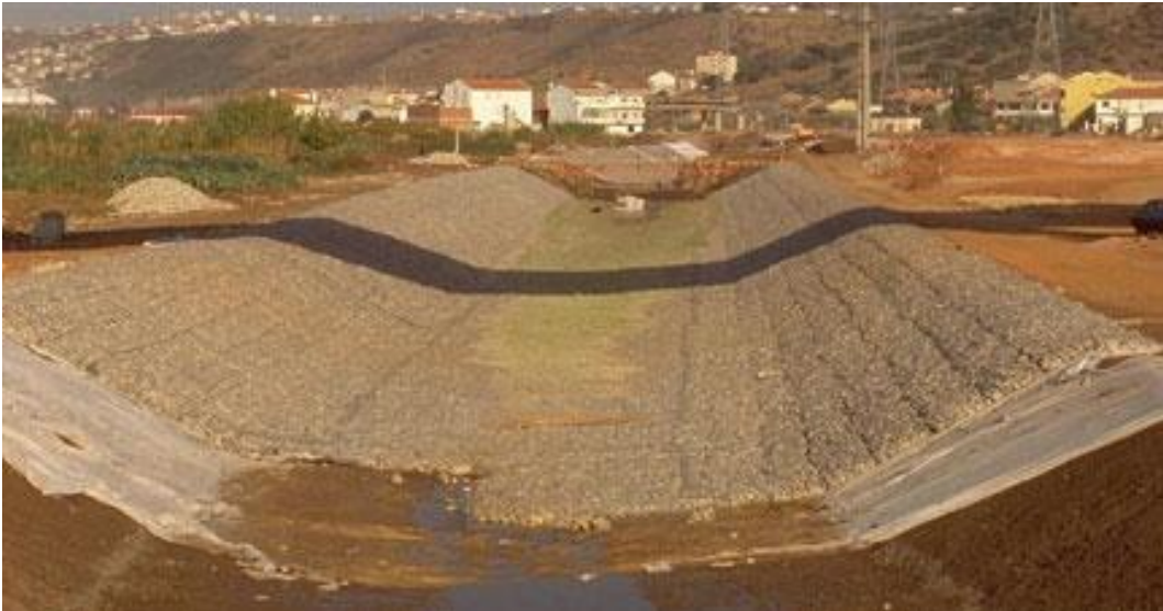
Figura 2.18 – Exemplo de aplicação de colchões Reno, no fundo e margens de um canal artificial (Enrico Piolanti, Lda, 2002).
