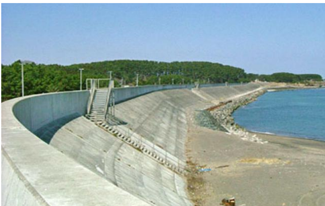
Figura 2.35 – Imagem de um muro de mar localizado no Japão (UAF-GI, 2010).
