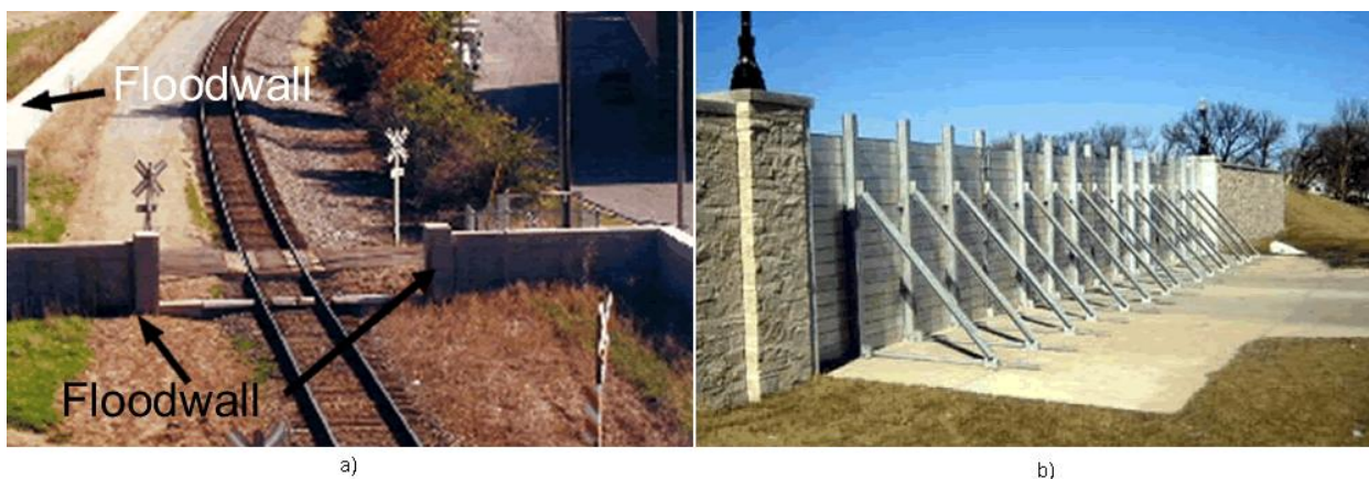
Figura 2.26 – Imagens de estruturas de encerramento: a) Estrutura tipo portão; b) Estrutura tipo comporta (USACE, 2008a).
