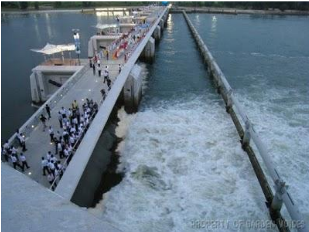
Figura 2.36 – Imagem de um sistema de comportas aplicado na entrada da cidade de Marina Bay em Singapura (DOASM, 2010).
