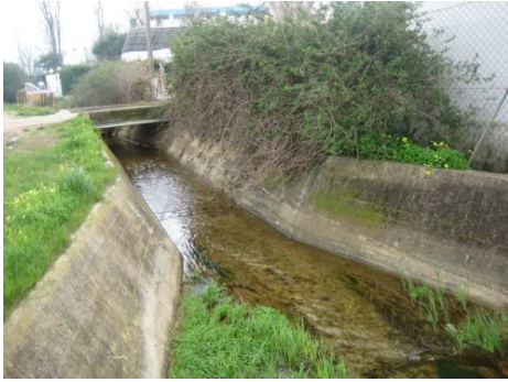
Fig. 38 – Margens da ribeira regularizadas em betão, início do subtroço 5 (vista de montante); Vânia Rodrigues
