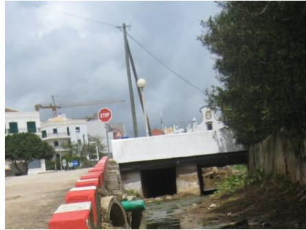
Fig. 46 – Passagem hidráulica, final do subtroço 1 (vista de jusante); Vânia Rodrigues
