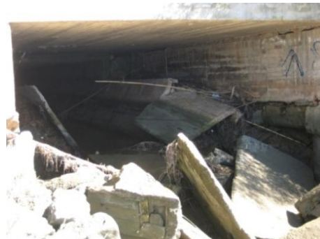
Fig. 41 – Extremidade do canal destruído (vista de jusante); Vânia Rodrigues
