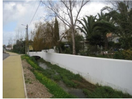
Fig. 32 – Linha de água limitada entre muros de particulares e a ciclovia (vista de jusante); Vânia Rodrigues
