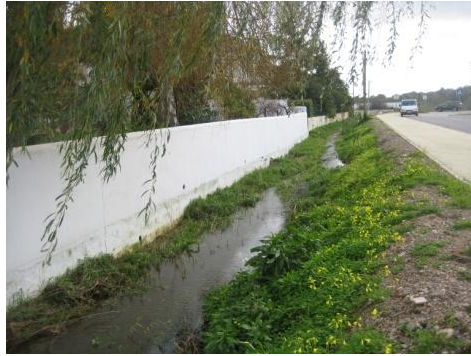
Fig. 48 – Perfil da linha de água, subtroço 3 (vista de montante); Vânia Rodrigues
