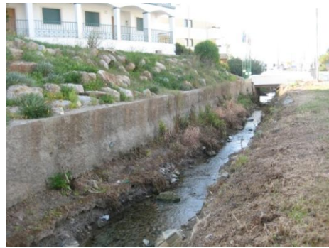
Fig. 22 – Final do subtroço 1 (vista de montante); Vânia Rodrigues
