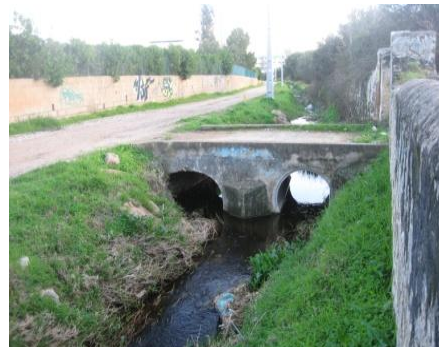
Fig. 50 – Última passagem hidráulica, subtroço 4 (vista de montante); Vânia Rodrigues
