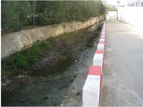
Fig. 24 – Ribeira contida entre muros, início do subtroço 2 (vista de montante); Vânia Rodrigues
