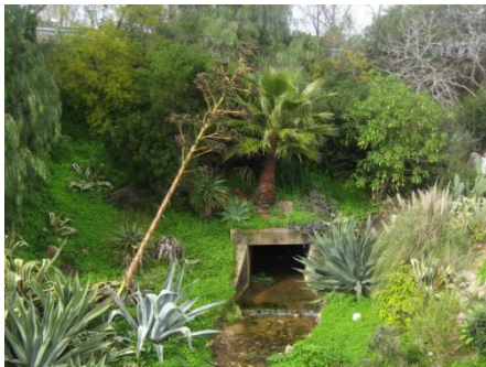
Fig. 12 – Início da Ribeira da Canada em Perímetro urbano (vista de jusante); Vânia Rodrigues
