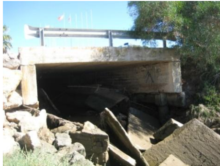
Fig. 51 – Extremidade Sul do canal, subtroço 5 (vista de jusante); Vânia Rodrigues
