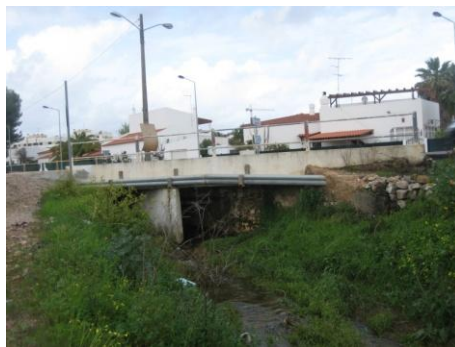
Fig. 47 – Passagem hidráulica, final do subtroço 2 (vista de jusante); Vânia Rodrigues
