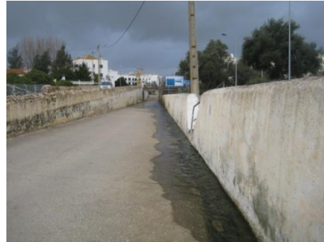
Fig. 25 – Linha de água transborda, inundando a passagem inferior da Rua Capitão Jorge Ribeiro (vista de jusante); Vânia Rodrigues
