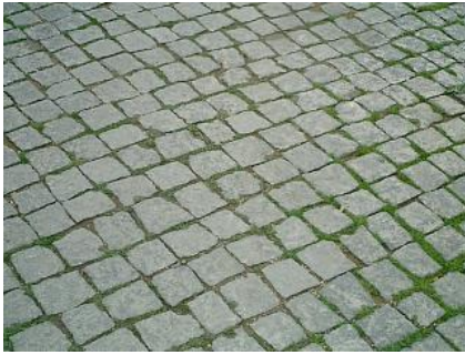
Fig. 75 – Calçada de vidro cinza; Vânia Rodrigues
