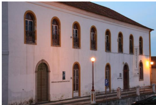
Figura 59 - Edifício da Biblioteca Municipal – Almeida Faria, em Montemor-o-Novo
