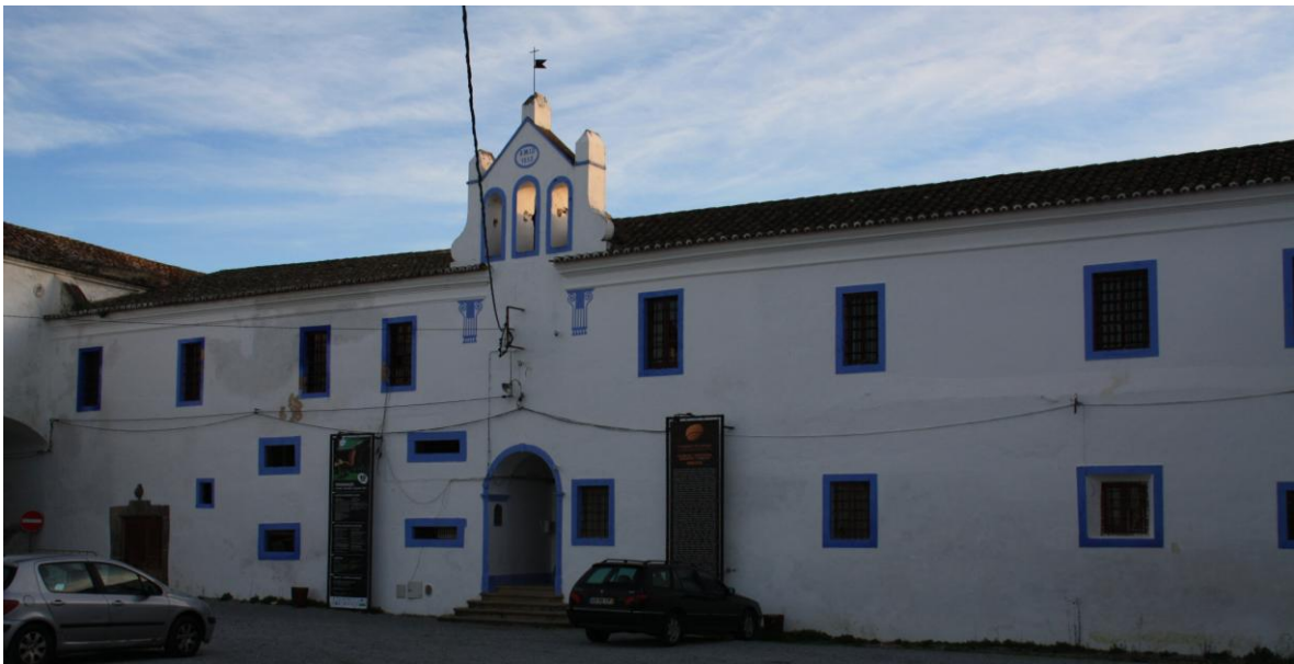
Figura 8 - Fotografia do Convento de Nossa Senhora da Saudação, Montemor-o-Novo
