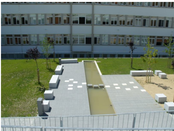
Figura 10 – O efeito da água da chuva e a deficiente aplicação das técnicas construtivas originou a entrada de sedimentos no interior do plano de água, o que resultou no seu aspeto turvo. Espaço aberto central da Escola de São Lourenço, em Portalegre (projeto de arquitetura paisagista elaborado pela equipa da AP Estudos e Projetos de Arquitectura Paisagista Lda, 2009 – Foto do Autor).
