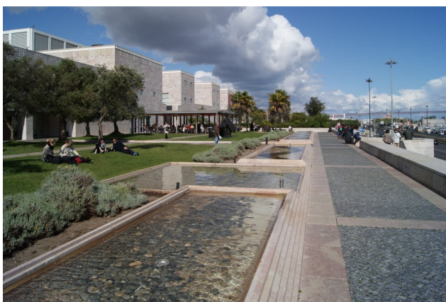
Figura 3 – A água adquire as características do seu contentor. Este elemento de água possui forma regular, materializando-se na forma de massas de água retangulares, cujo fundo, revestido de seixos rolados, confere à água uma maior continuidade com o pavimento envolvente, para além de um maior efeito dinâmico na aparente estaticidade. Centro Cultural de Belém, Lisboa (Foto do Autor, 2012).
