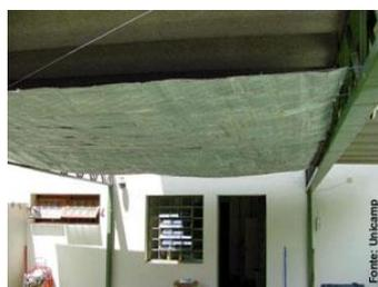
**Forro feito com embalagens de leite. Para garantir uma boa reflexão do calor o forro não deve encostar no telhado, mantendo uma distância de 2 cm**
