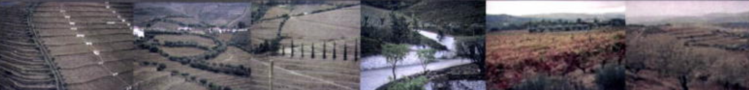
Bordadura de oliveira (dir.; centro) e de ciprestes (esq.) Muros caídos Vinha e olival Vinha e amendoal
