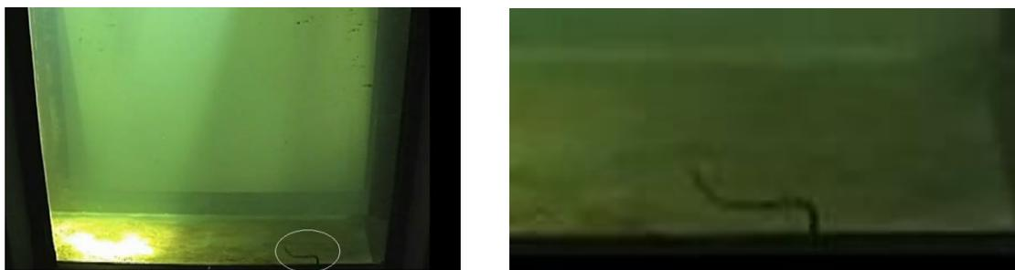
Figura 56 - Enguia-europeia a refugiar-se na fenda entre o vidro da janela de visualização e a rampa de passagem da PPP.
