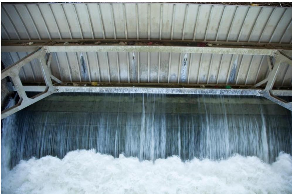
Figura 3 - Pormenor de abertura de uma comporta no Açude-Ponte de Coimbra.
