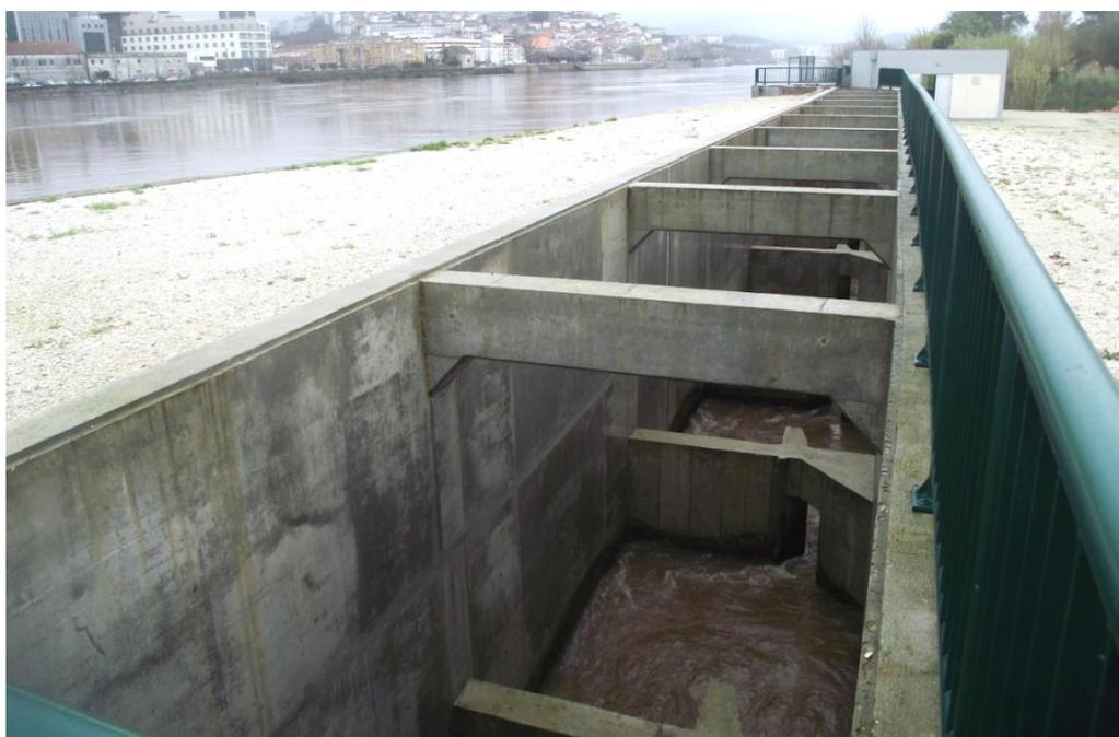
Figura 4 - PPP do Açude-Ponte com pormenor das bacias sucessivas e das fendas verticais que permitem a comunicação entre bacias.
