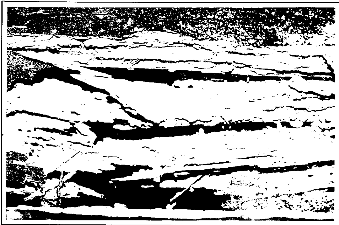
Fig. 8.19 - Mosteiro de S. Bernardo de Portalegre. Igreja. Ataque de Anobium punctatum no estrado do coro baixo.
