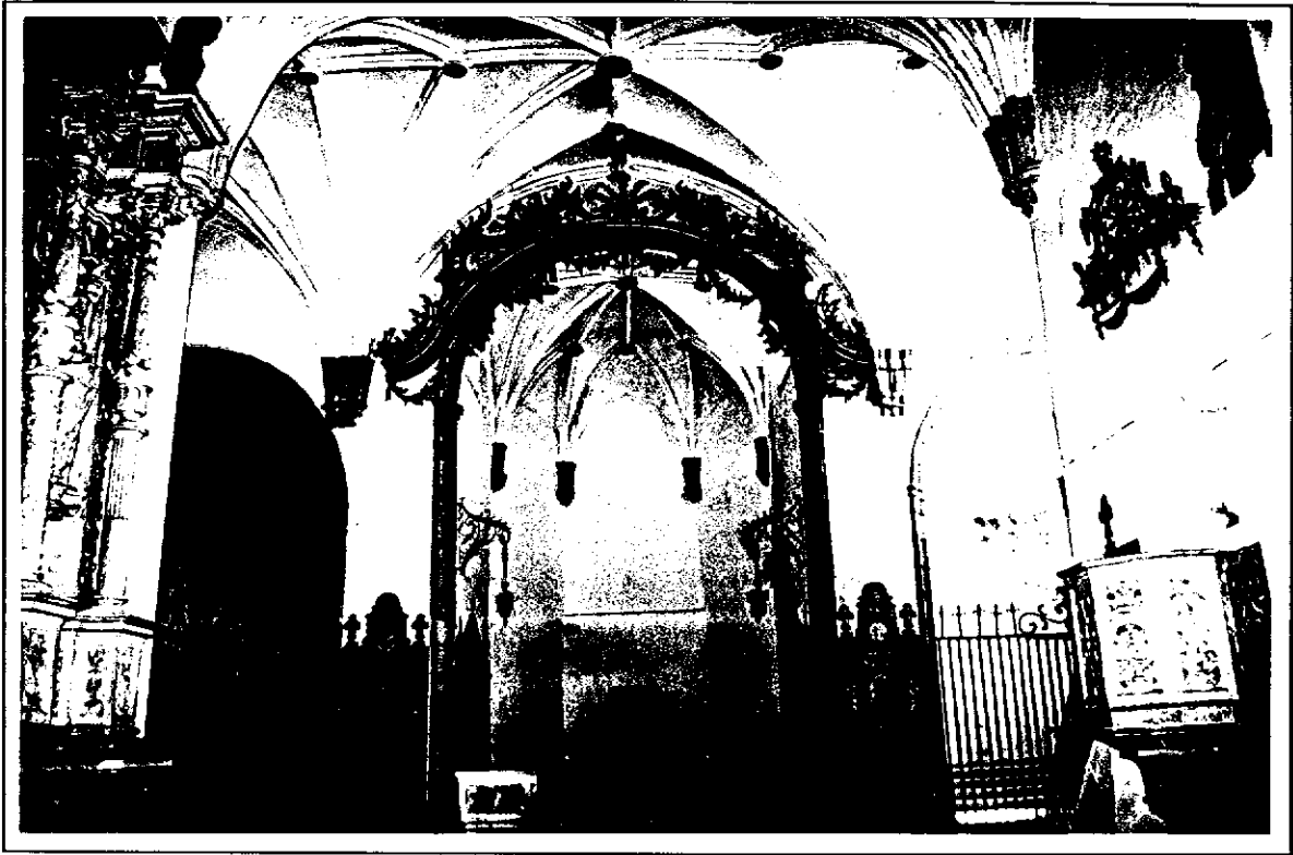
Fig. 3.2 - Mosteiro de S. Bernardo de Portalegre. Igreja, alçado da cabeceira.
