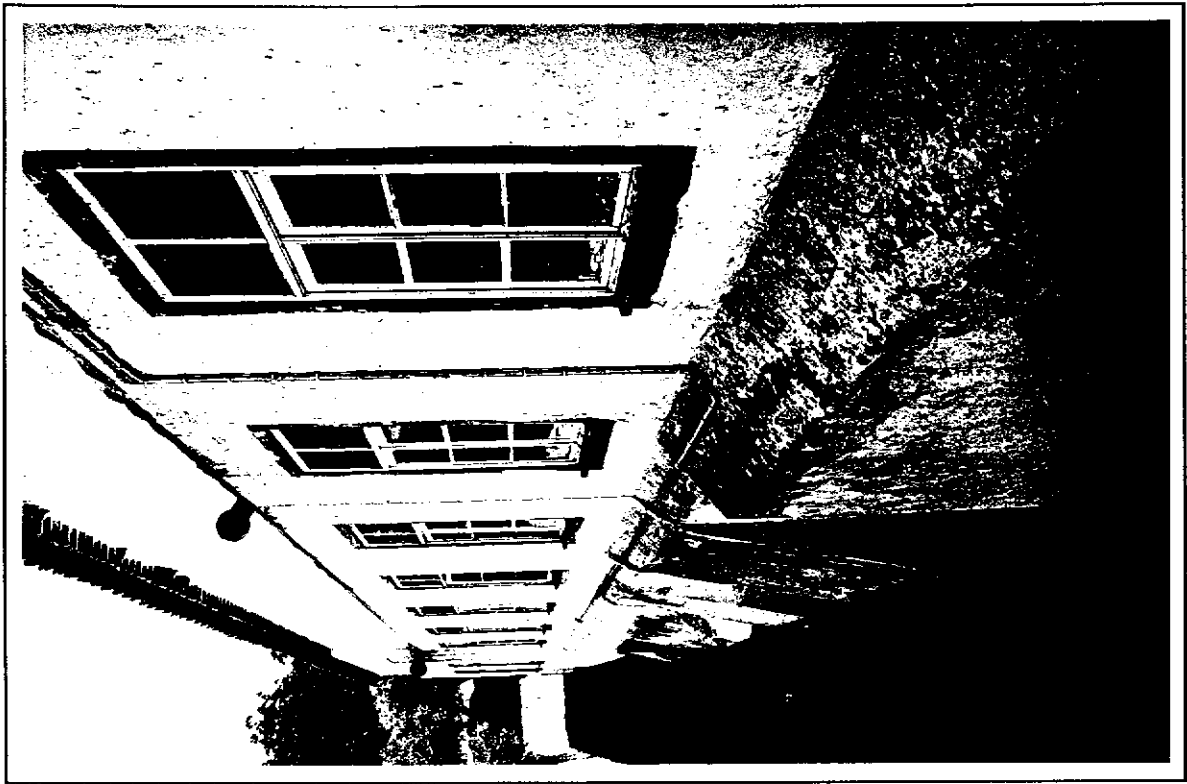
Fig. 5.7 - Mosteiro de S. Bernardo de Portalegre. Alçado exterior da ala norte do claustro nascente. Embasamento e coluna de esgotos.
