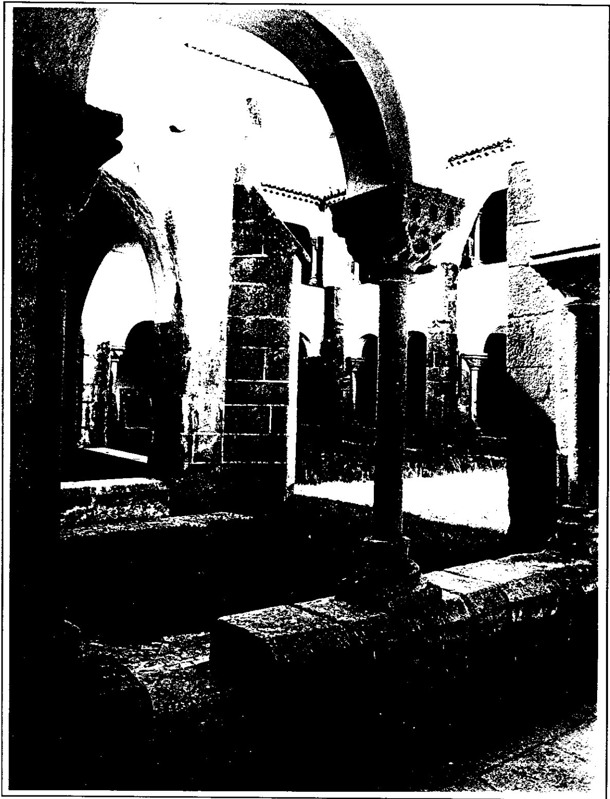
Fig. 3.15 - Mosteiro de S. Bernardo de Portalegre. Claustro nascente.
