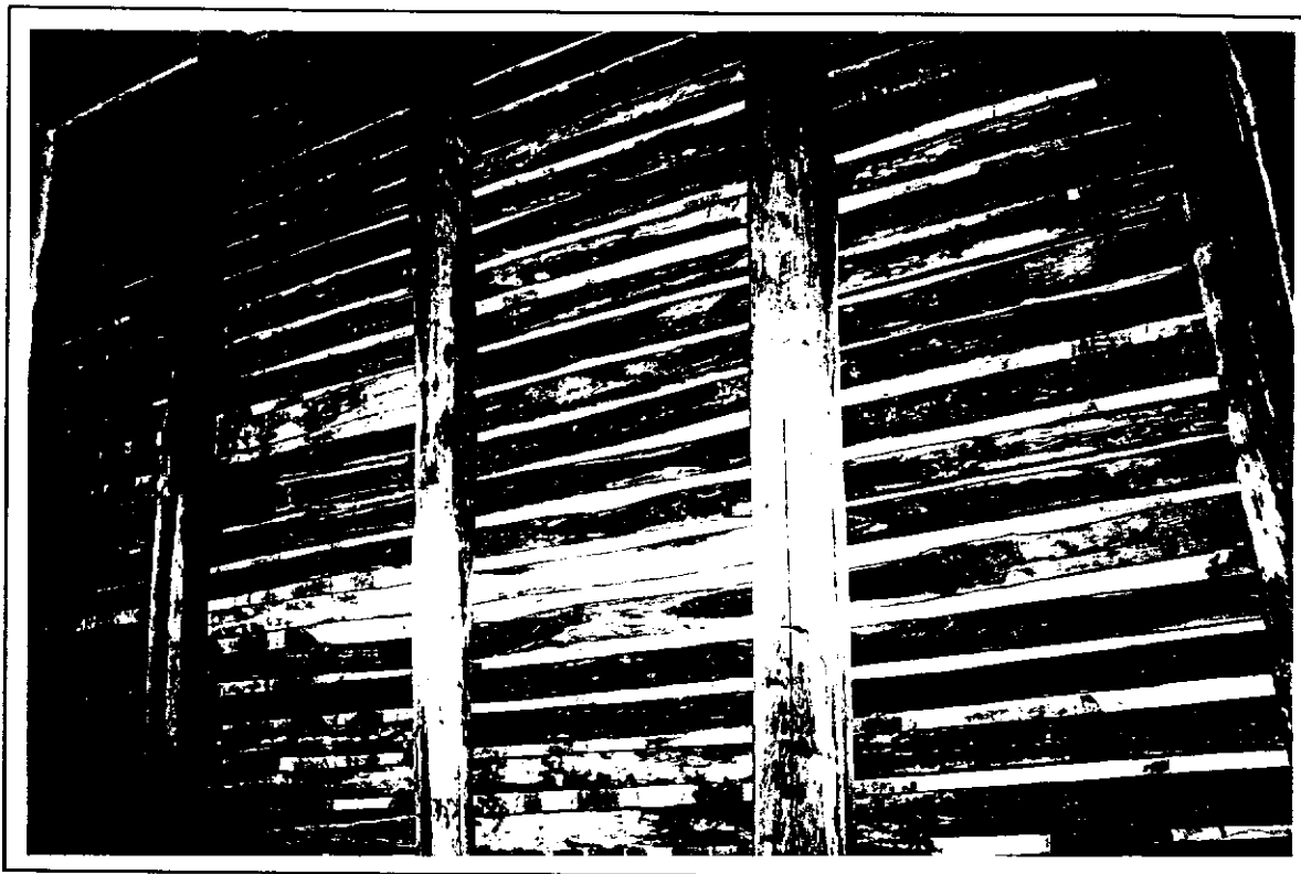
Fig. 4.10 - Mosteiro de S. Bernardo de Portalegre. Salas contíguas à igreja. Pavimento de tijoleira visto de baixo.
