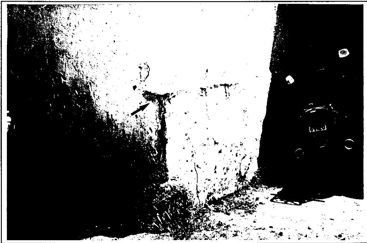
Fig. 9.3 - Mosteiro de S. Bernardo de Portalegre. Marca exterior da cota do piso térreo do claustro poente.
