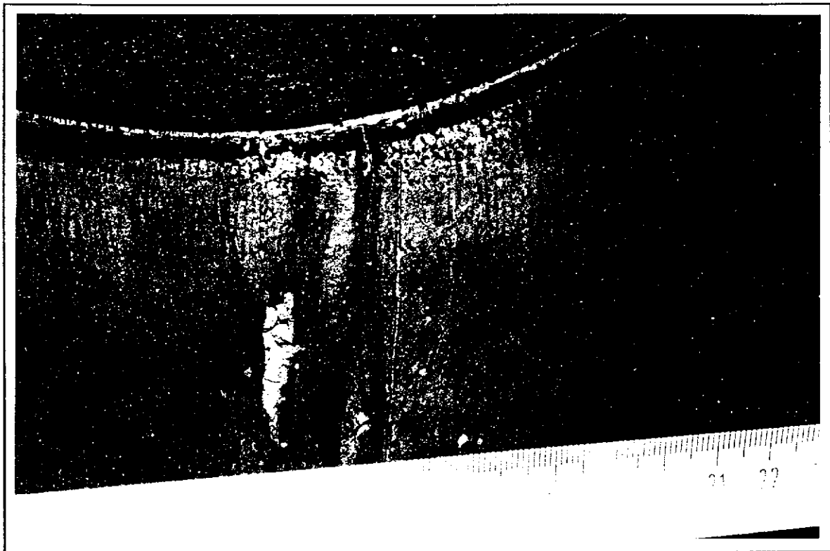
Fig. 8.21 - Mosteiro de S. Bernardo de Portalegre. Igreja. Cadeira do coro baixo. Ataque de Anobium punctatum .
