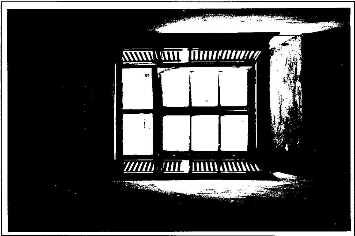
Fig. 4.8 - Mosteiro de S. Bernardo de Portalegre. Casa do confessor. Janela vista do interior.
