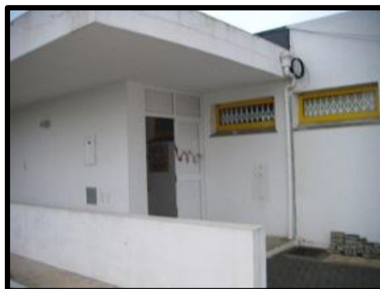
Fig. 2 - Porta acesso Hall de Entrada
