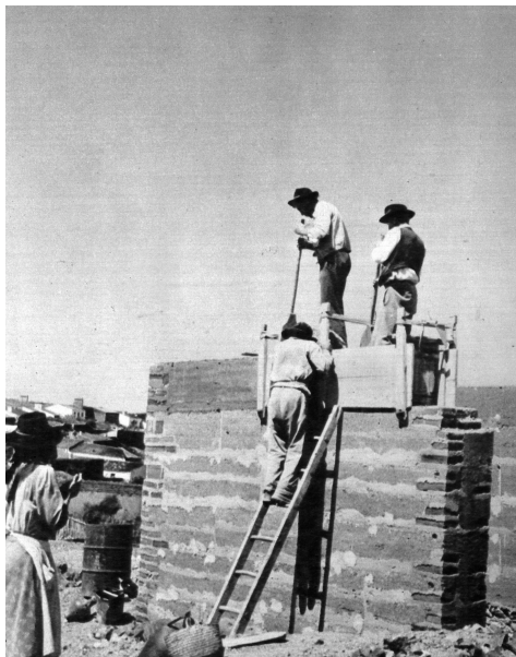
Fig. 8 - Construção de parede em taipa. A utilização de paredes grossas permite um aumento da inércia térmica. (AA.VV. – Arquitectura Popular em Portugal, 1988)
