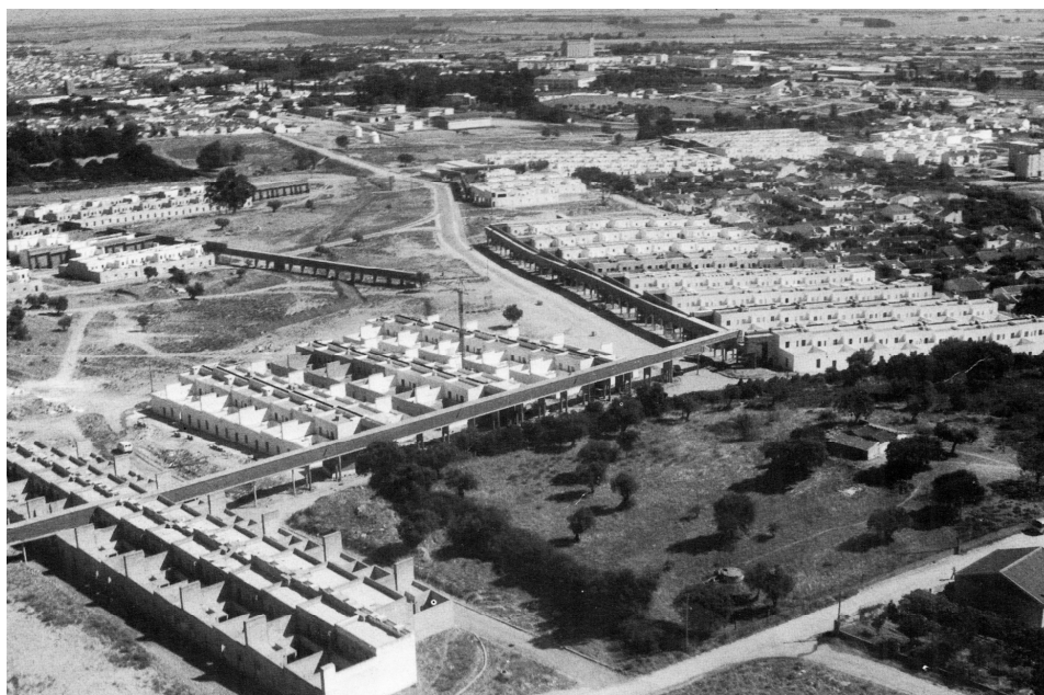
Fig. 11 - Vista aérea do Bairro da Malagueira (MOLTENI, 1997)
