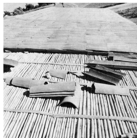
Fig. 9 – Cobertura na arquitectura popular. A utilização de um ripado de canas na cobertura permitia a constituição de uma caixa de ar rudimentar. (AA.VV. –
