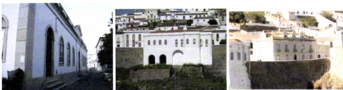
Edifício do antigo Tribunal Comarcal, que assenta sobre as sapatas da antiga casa da alcaidaria-mor (à esquerda); o mesmo edifício, construído sobre e exteriormente à muralha (ao centro); edifício particular, de tipologia “casa de brasileiro”, também oitocentista, posteriormente doado à Câmara e onde hoje funciona a referida Divisão Sócio-cultural.
