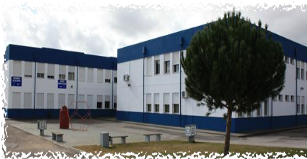
Figura 1 – Instalações exteriores da Escola Secundária de Vendas Novas
