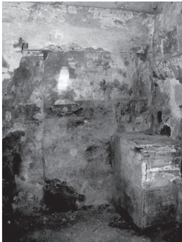
Foto 8: Puerta cegada en la pared sur
