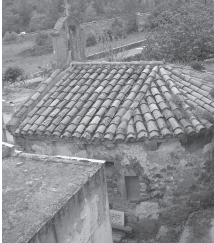
Foto 3: Exterior de la capilla desde el lateral sur.
