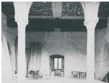
43. A laje colocada na terceira sala da Galleria delle Sculture , construída em 1963 com vigas de betão e elementos aligeirantes.
