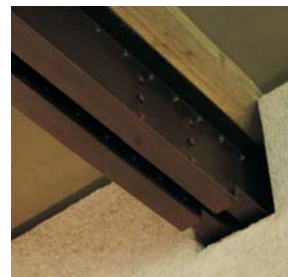
123. Pormenor do encontro entre a viga em ferro, a laje de betão e a parede com reboco em cal apagada da Galleria delle Sculture
