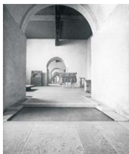
107. O pavimento em pietra di Prun, as paredes revestidas com cal apagada, a viga em aço e os suportes expositivos da Galleria delle Sculture
