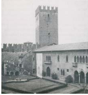
69. Fotomontagem do pano de fachada da ala della Galleria a demolir para a colocação da estátua equestre de Cangrande della Scala .
