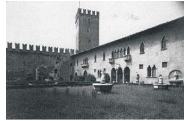
17. O jardim do pátio de entrada e a fachada da ala della Galleria após a intervenção de restauro estilístico realizada entre 1924 e 1926 por Antonio Avena e Ferdinando Forlati.
