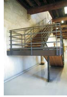
27. Escada que liga o primeiro e o segundo piso da ala della Reggia . Construída com estrutura portante em vigas de ferro à vista e degraus com tábuas de nogueira Mansonia .
