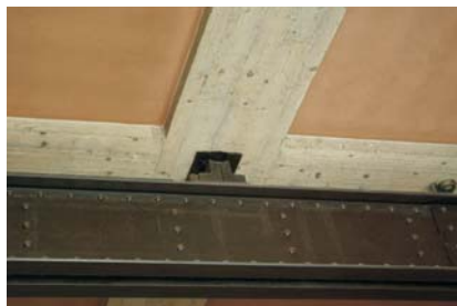
122. Viga em ferro colocada na Galleria delle Sculture
