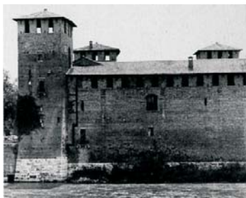
85. Desenho de Carlo Scarpa sobre uma fotografia, estudando a possibilidade de realizar um corte no muro Ottocentesco , criando uma divisão entre a torre e o muro próximo ao Adige
