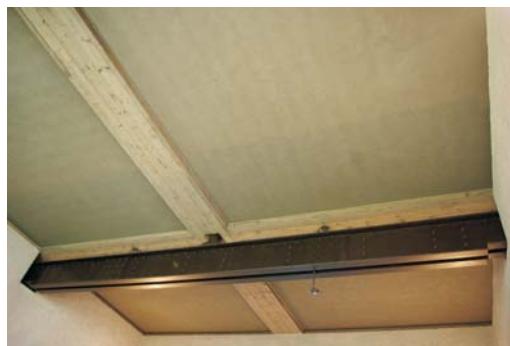
51. Viga em ferro, de apoio à laje construída com vigas de betão e elementos aligeirantes, construída entre 1961 e 1964.
