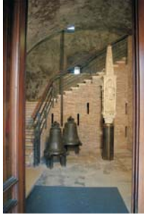
24. Escadas de acesso ao primeiro piso da ala della Reggia , situadas no piso térreo do Mastio . A estrutura foi realizada com tijolos cozidos e os degraus revestidos com pietra di Prun .
