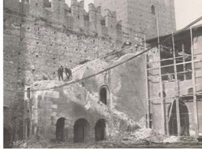
70. Trabalhos de demolição da escada oitocentesca que, no museu aveniano ligava o primeiro piso da Galleria com o jardim do pátio de entrada. A demolição da escada permitiu descobrir o muro urbano do século XII.
