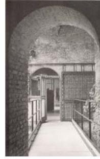
26. Passagem em betão suspensa que liga o Mastio ao primeiro piso da ala della Reggia .
