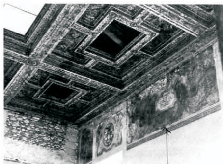
50. Tecto em caixotões de madeira, situado na ala della Galleria , antes de ser demolido durante a intervenção de restauro realizada entre 1961 e 1963.
