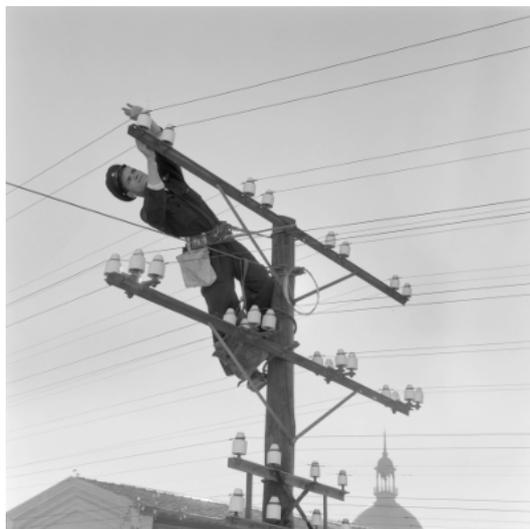
Figura 52 – Guarda-Fios a trabalhar na instalação da linha telefónica Lisboa/Sacavém.
