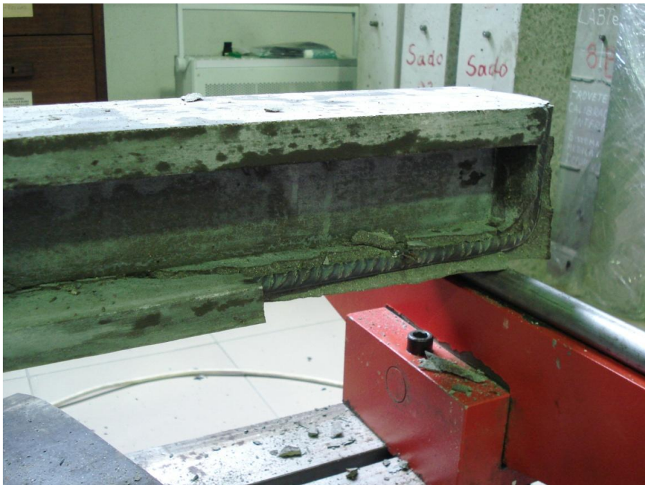
Figura 4.46: Pormenor da zona de rotura da Viga 3 (2), na zona do apoio
