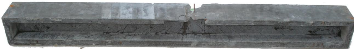
Figura 4.64: Aspecto da Viga 7 após rotura.
