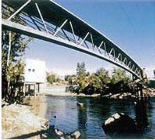
Figura 3.1: Passarela de Sherbrooke (téchne)
