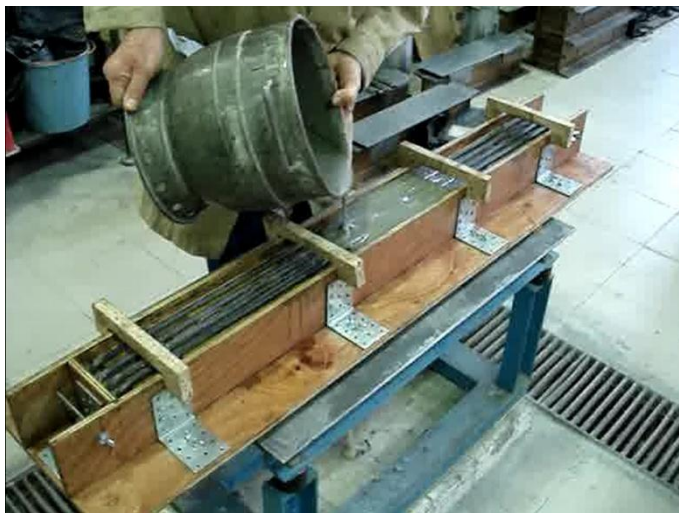
Figura 4.16: Betonagem da Viga 1
