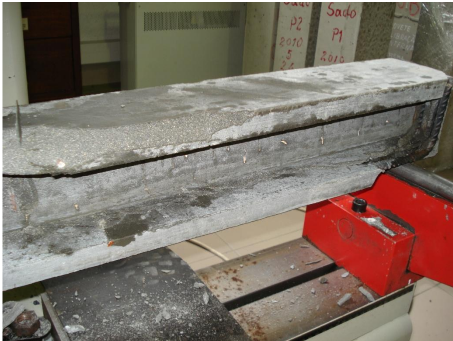
Figura 4.40: Pormenor da zona de rotura da Viga 3 (2), junto ao apoio.
