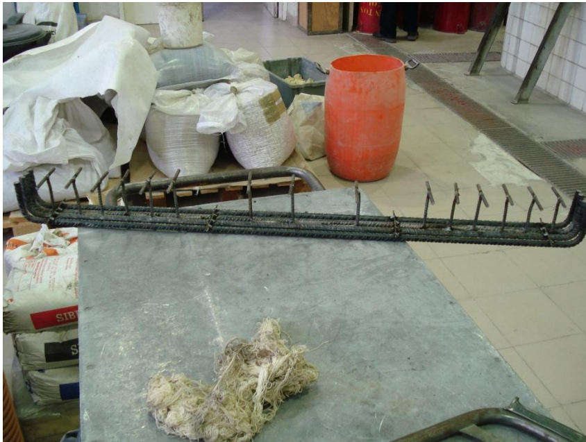
Figura 4.23: Armadura da Viga 2
