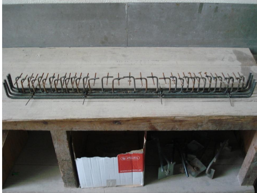
Figura 4.31: Armadura da Viga 3
