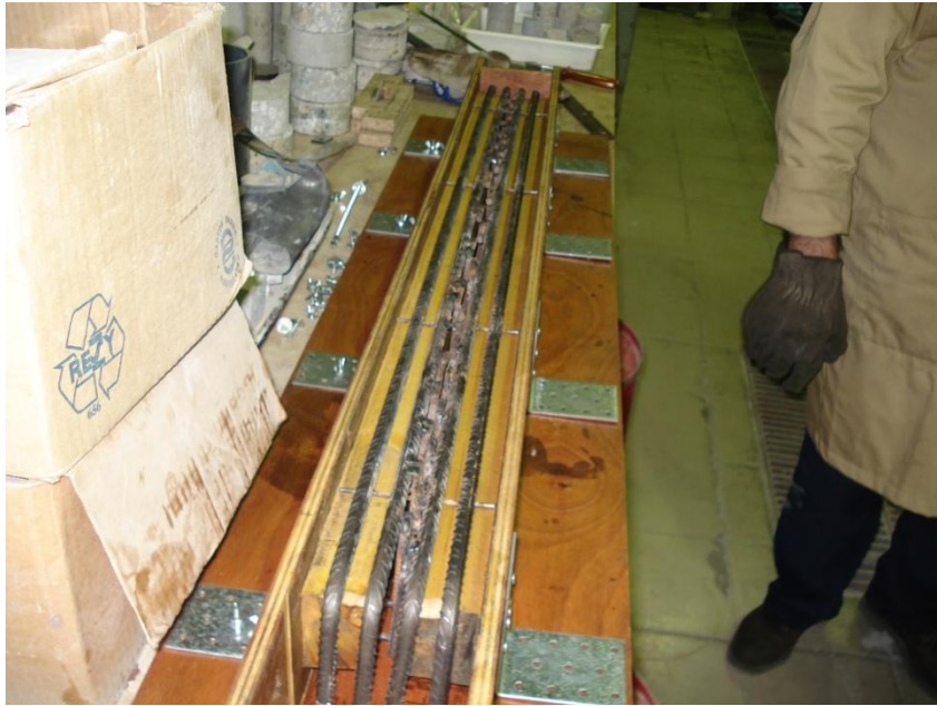
Figura 4.5: Vista geral da armadura fixa ao molde
