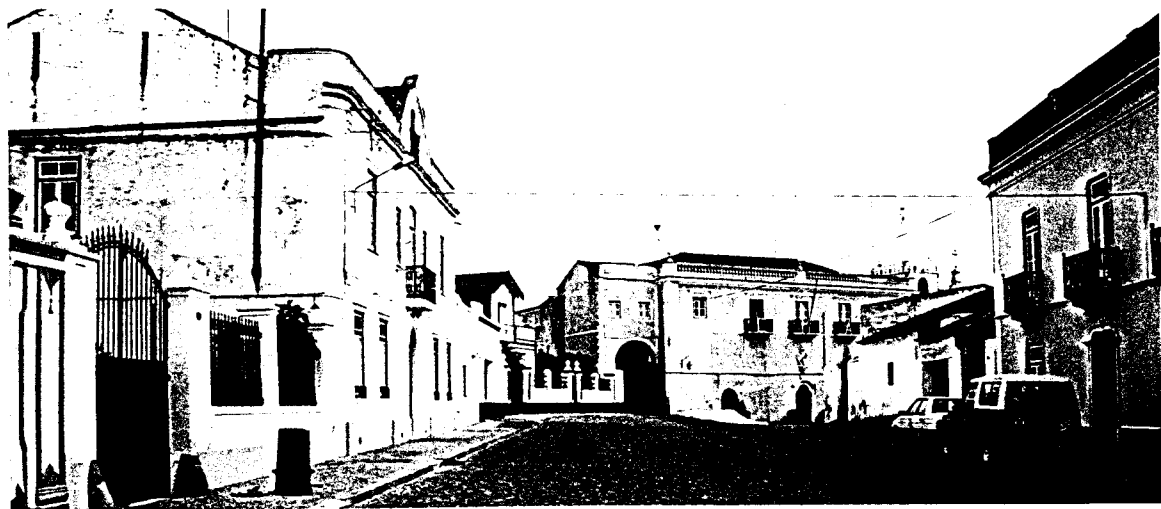
Fig. 1 - Panorâmica das antigas estruturas da Ordem de S. Bento de Avis.
