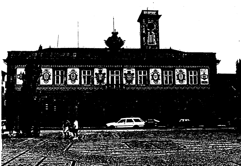
Fig. 1 - O edifício da Câmara Municipal, com a fachada resultante das intervenções do princípio do século.
