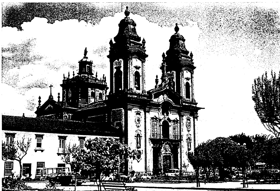
Fig. 2 - Fachada da igreja do convento.
