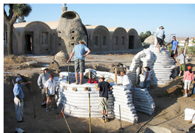
Figura 12 -Construção das casas com sacos de terra.
