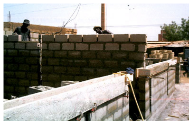
Figura 64- Construção da escola comunitária, Bamako, Mali.
