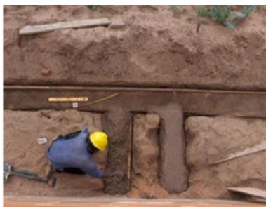
Figura 99- Embasamento das instalações sanitárias.
