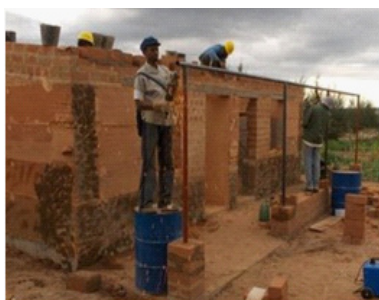
Figura 98- Assentamento dos blocos de betão e armadura no alpendre
