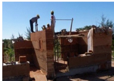
Figura 95- Colocação dos blocos de taipa.
