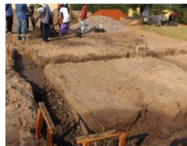
Figura 91- Valas do enrocamento.
