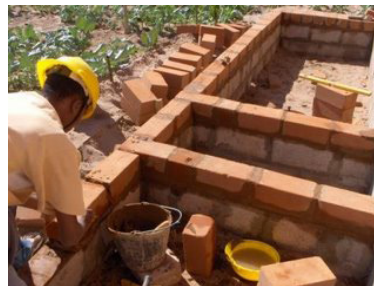
Figura 100- Assentamento dos blocos de BTC.
