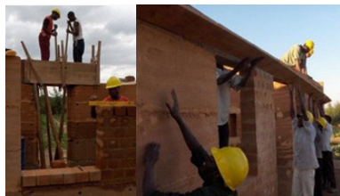
Figura 97- Colocação dos Taipais na fachada e janelas.
