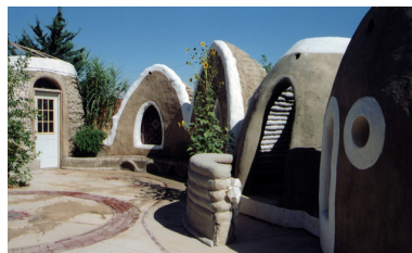
Figura 12 -Construção das casas com sacos de terra.
