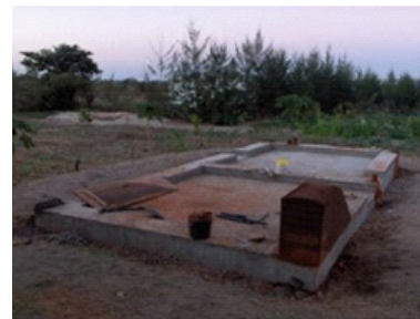
Figura 93- Plataforma em argamassa.
