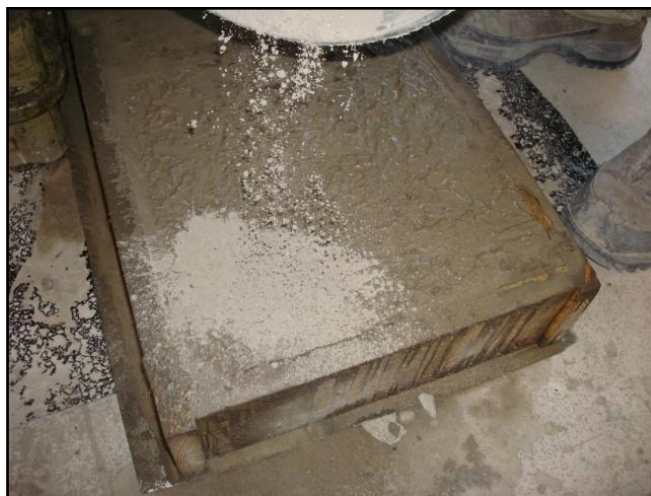
Figura 18 - Aplicação do endurecedor de superfície.
