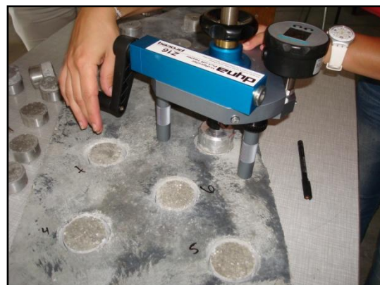
Figura 34 – Ensaio de arrancamento por pull-off.
