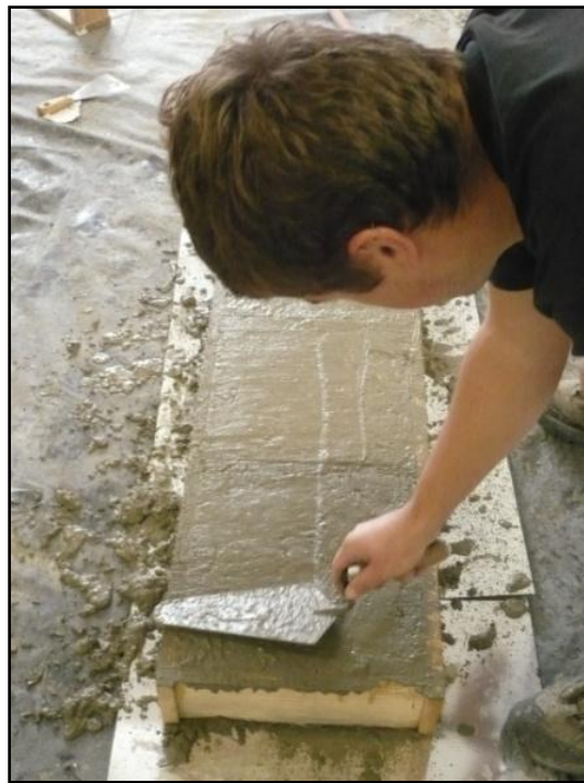
Figura 17 – Nivelamento do betão de base.
