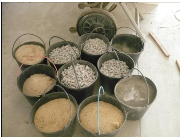
Figura 14 – Pesagens para o fabrico do betão.
