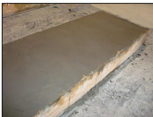
Figura 20 – Superfície obtida depois do acabamento.
