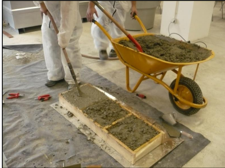
Figura 16 – Vibração do betão de base.
