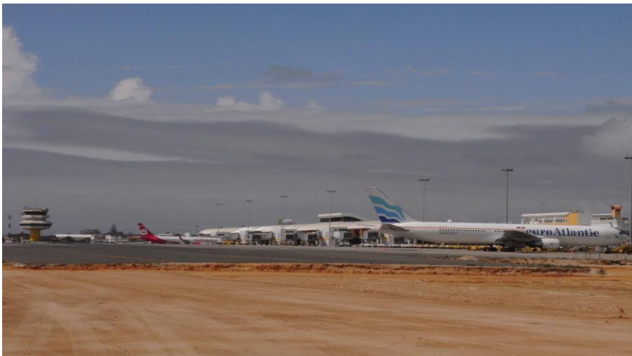
Figura n.º 4: Camada de leito de pavimento na Plataforma Estacionamento S2
