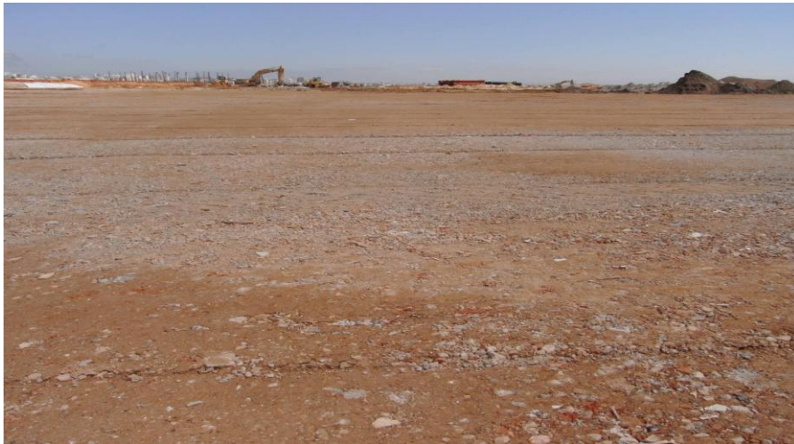
Figura n.º 3: Camada de leito de pavimento no Taxiways "F"
