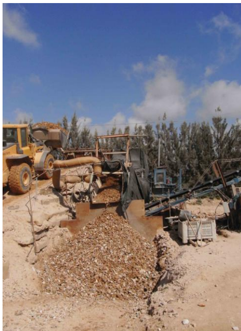
Figura 8 - Redução Primária: Fornecimento dos resíduos na britadeira
