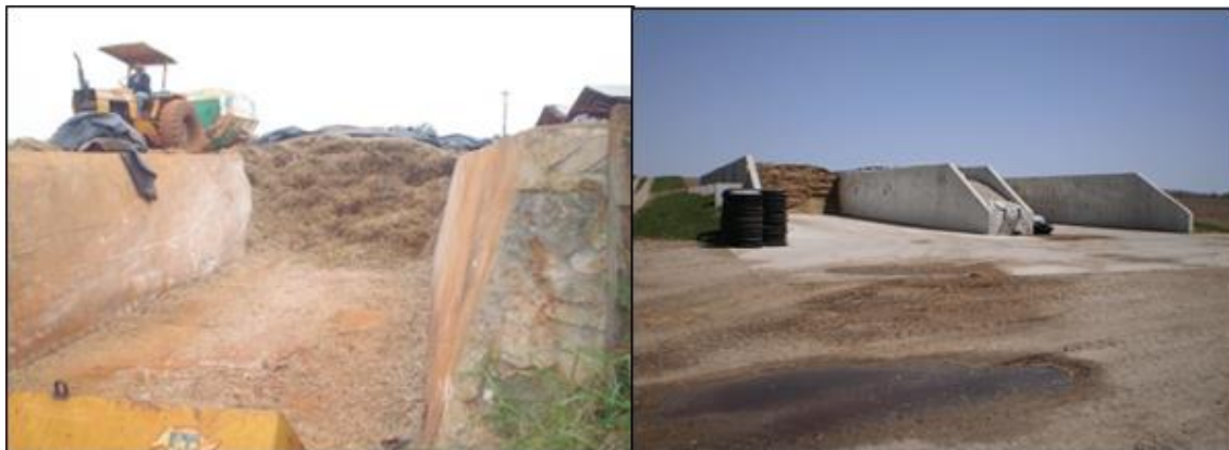
Figura 4 – Silo de trincheira ou bunker
